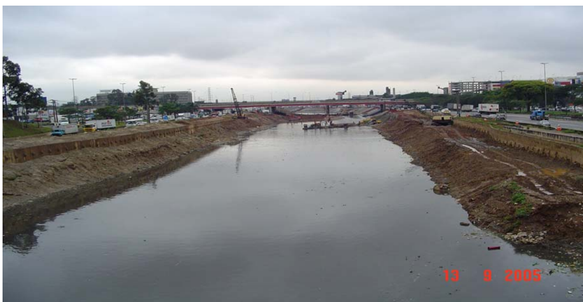
Foto 4.4.2 Obras de melhoria no canal do Rio Tietê (Foto do autor: Setembro de 2005).
