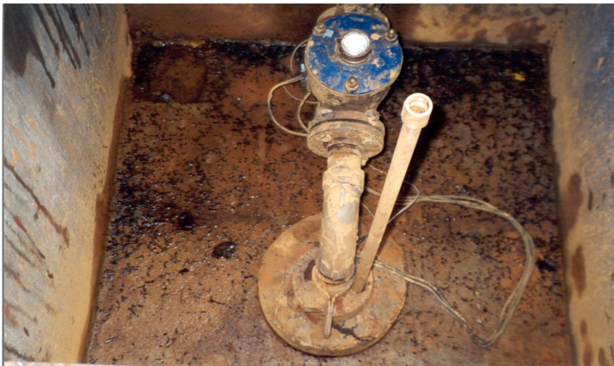
Foto 4.4.3 Poço tubular profundo contaminado (16mg/l) por ferro, (Foto do autor. Julho de 2001).
