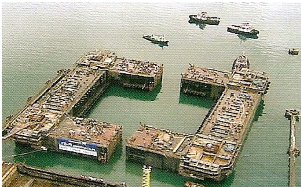
Figura 5.8 – Os dois “Cs” do casco da P-51
