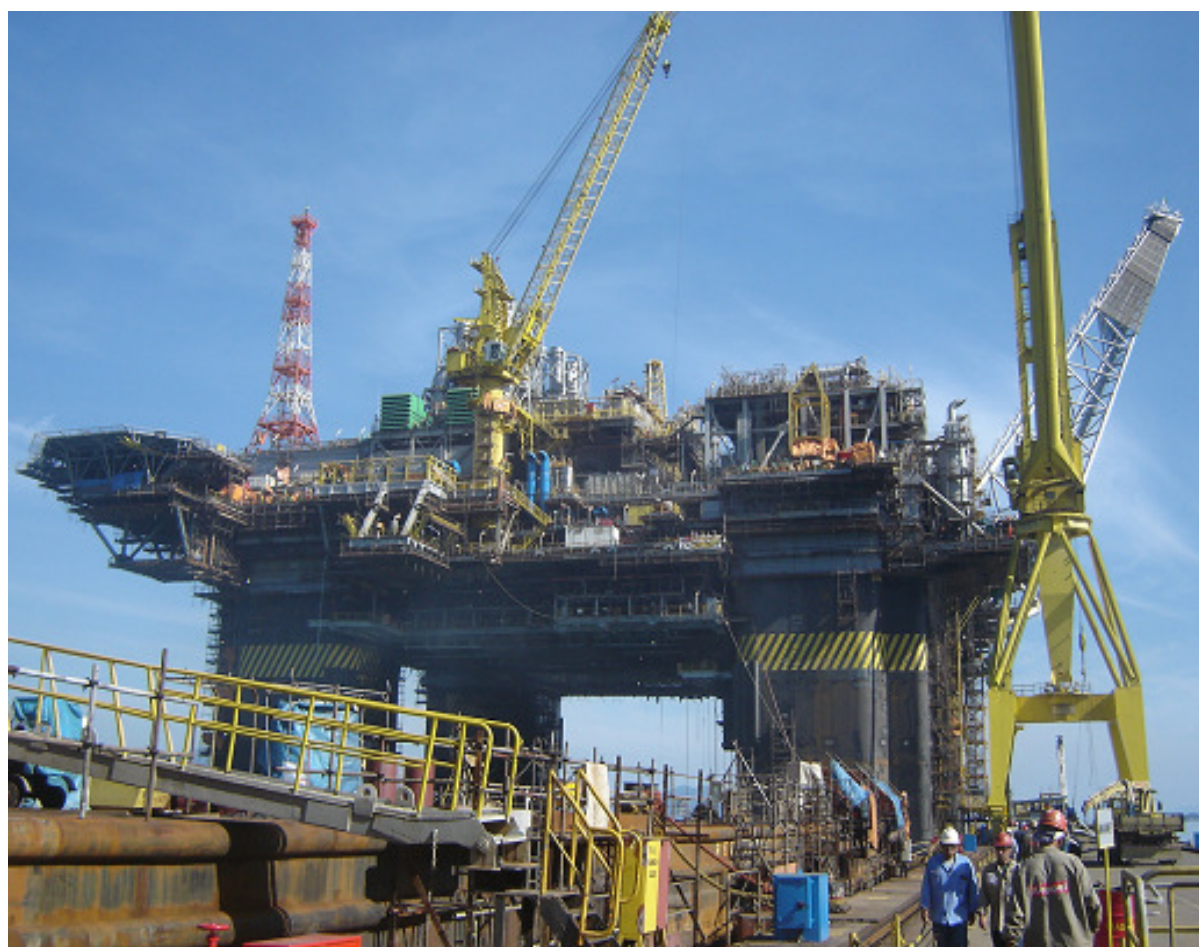
Figura 8.3 – Plataforma P-51 após a operação de deck-mating
