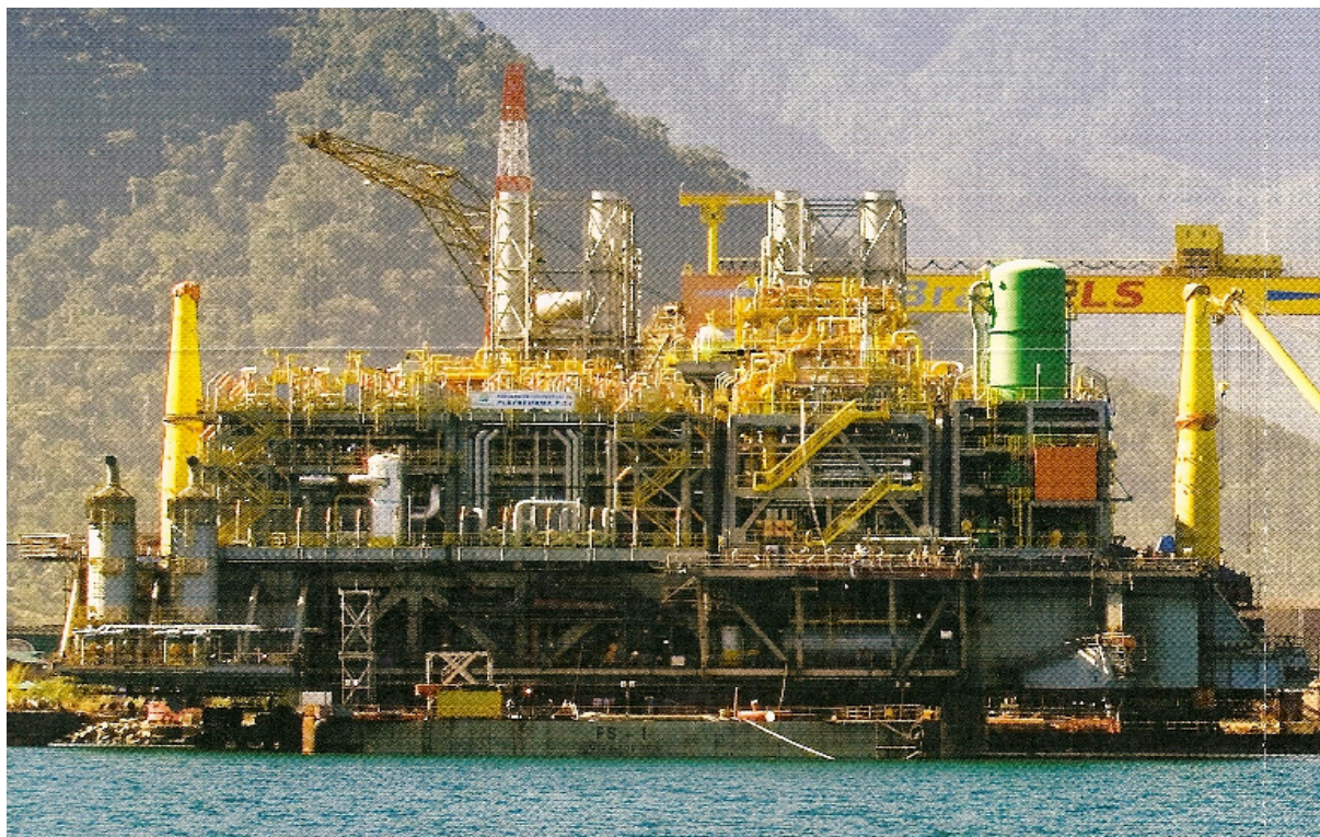
Figura 8.2 – Topside da plataforma P-51 sobre a balsa FS-1
