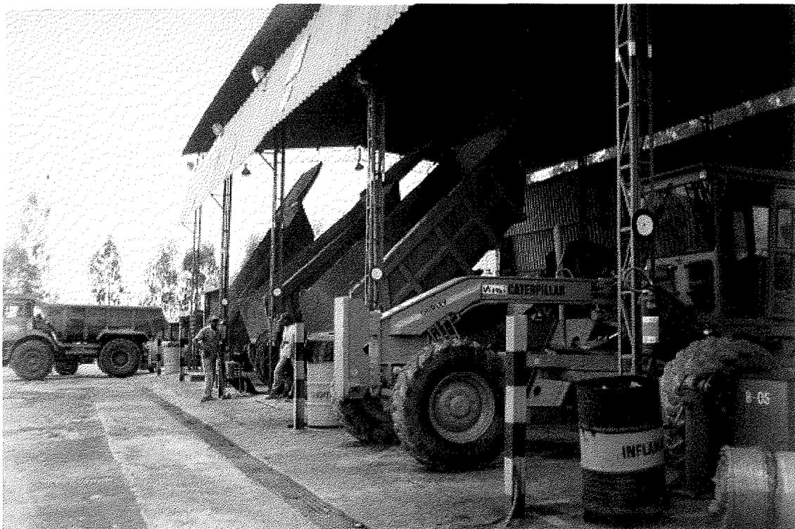
Foto 12 - Canaletas para coleta de óleo (caixas de passagem) na oficina de manutenção de veículos.
