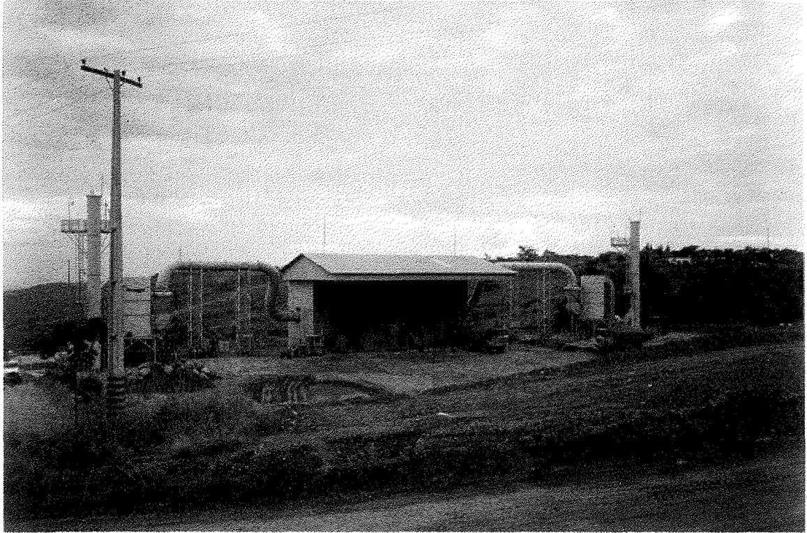
Foto 05 - Alimentação da usina de beneficiamento e sistema de exaustão de coleta de pó.
