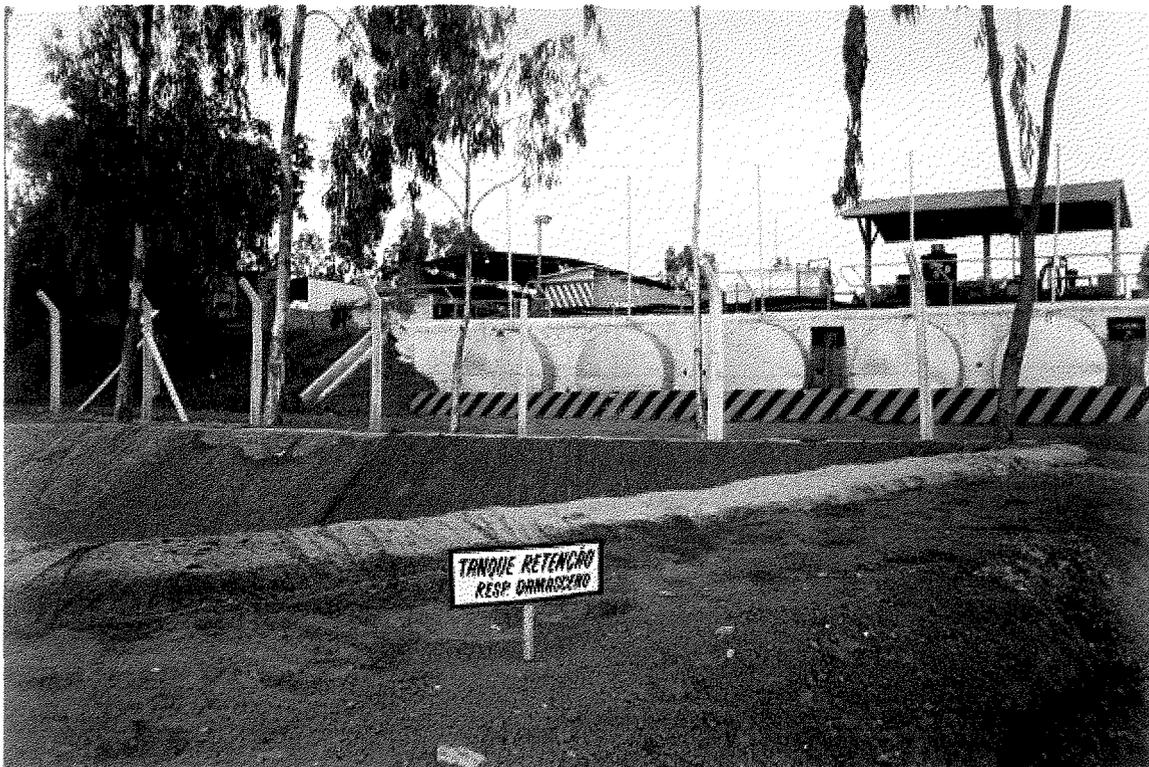
Foto 14 - Tanque de retenção em local de abastecimento de diesel.
