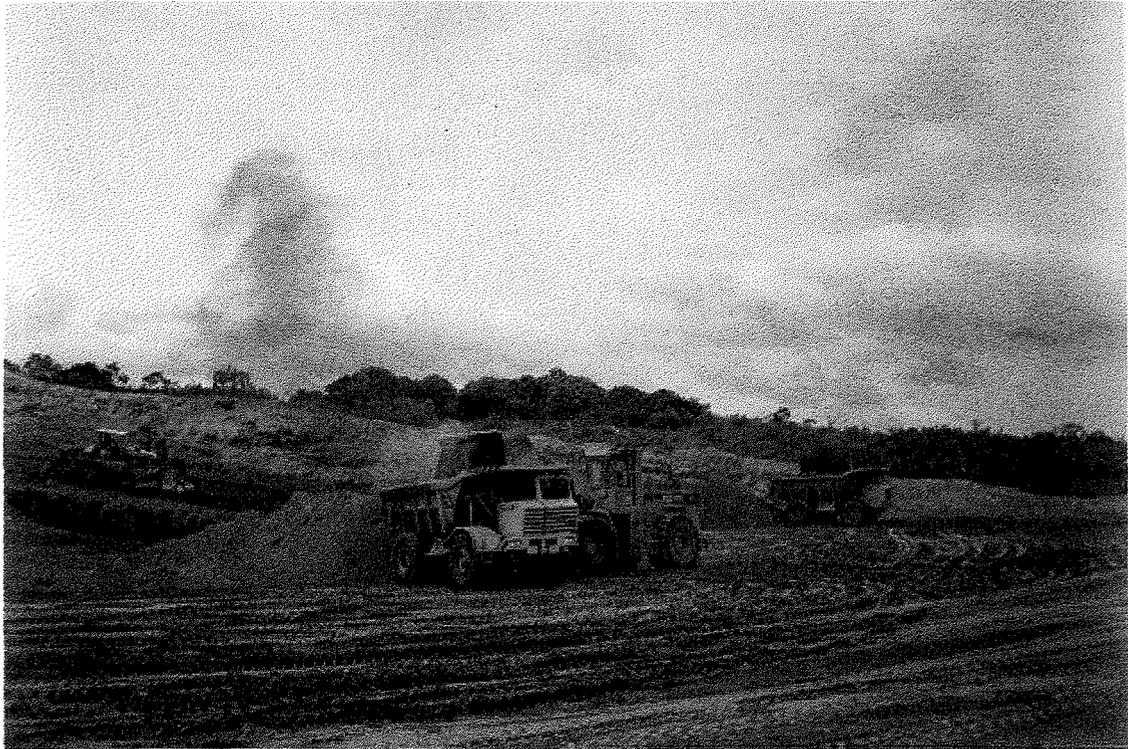
Foto 09 - Emissão de gases e poeira resultantes da movimentação das máquinas e das operações de lavra.
