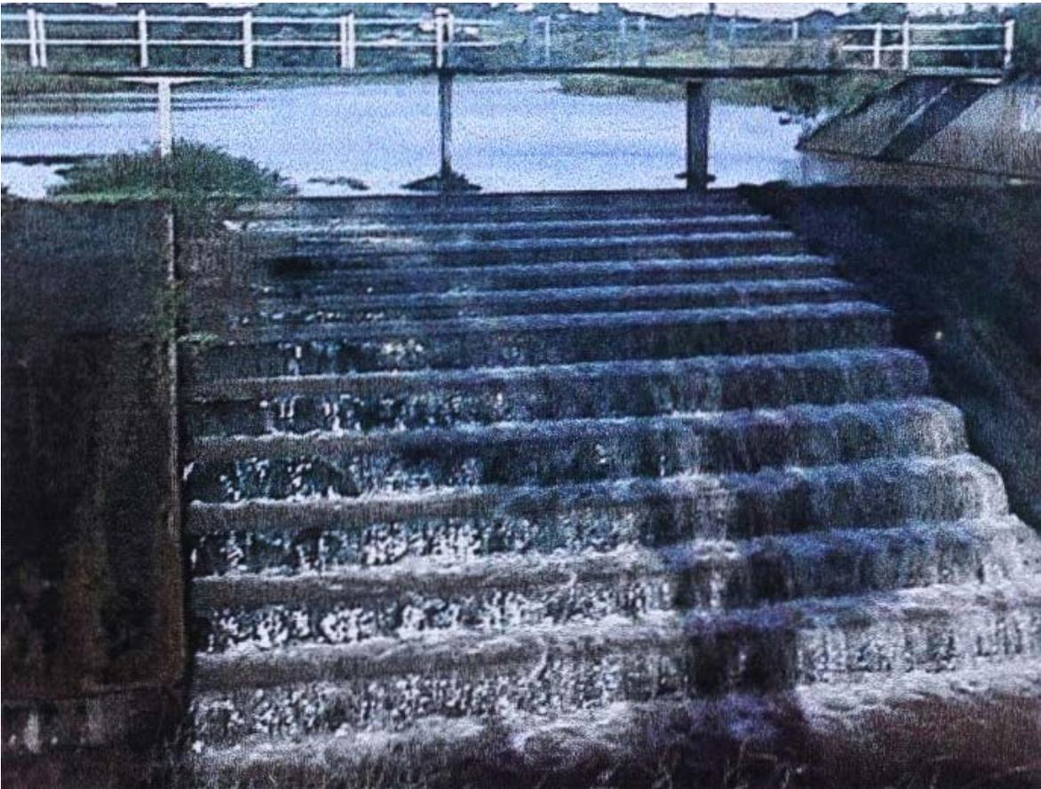
**Figura 7.3 – Vertedouro (escada d'água) da barragem do Rio Itaim-Guaçu.**
