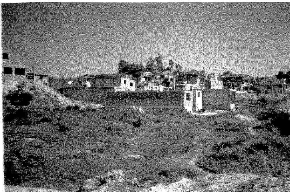
Foto14 : Área crítica de Urbanização do Jd. Santa fé. Notar o avanço da urbanização por sobre a linha de drenagem, em terrenos aluvionares capeados por aterros (solos moles). Área de risco, sujeita a alagamentos e recalques.
