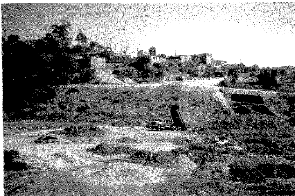
Foto 12: Frente de aterro do Jd. Santa Fé. Típico depósito tecnogênico, observe o corte no talúde, à direita, expondo material orgânico escuro. Área de Risco Geológico-geotécnico.
