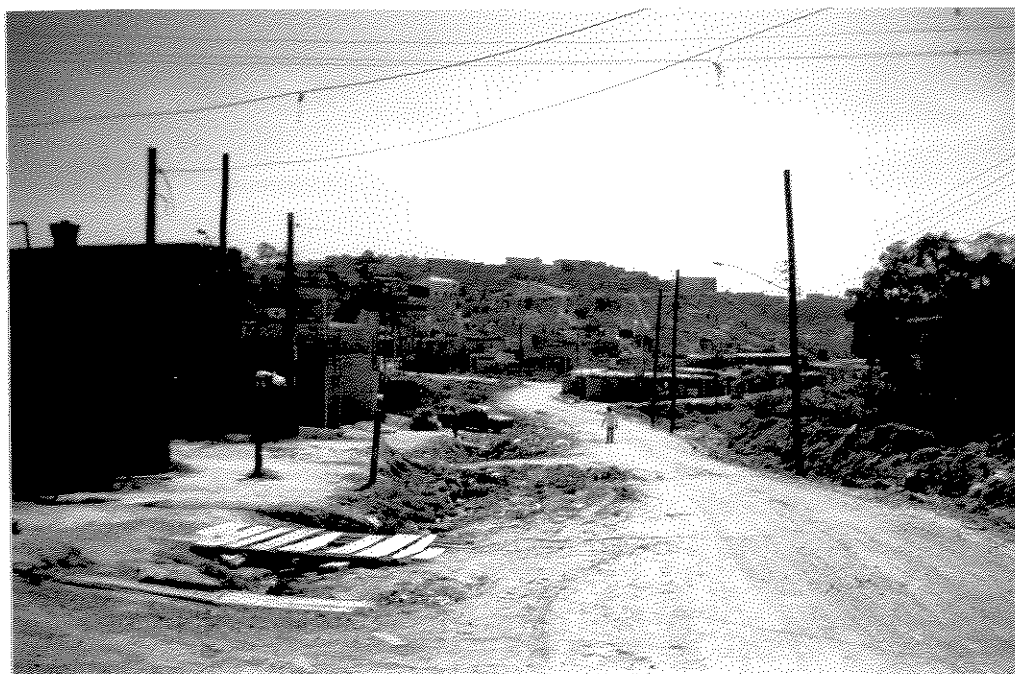
Foto 13: Jardim Santa Fé, loteamento clandestino sobre área caracterizada como Solos Moles, formada por aterros sobre a planície aluvial. Na parte baixa ao fundo, favela no entorno de linha de drenagem, no alto aterro sofrendo erosão. Área crítica de urbanização.
