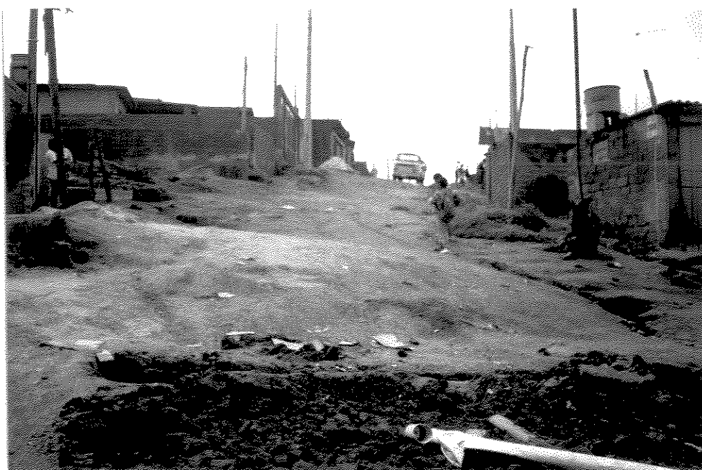
Foto 04: Loteamento clandestino Jd. Eliana, desprovido de saneamento básico como coleta de esgotos, lixo, água encanada, drenagem de águas pluviais e pavimentação de ruas. Ocorre erosão laminar e em sulcos, apesar da declividade inferior a 25% e solo superficial orgânico e argiloso, originado de Sedimentos da Bacia de São Paulo.
