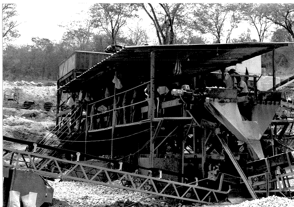
FOTO 4.2 - Mina da Cachoeira. Unidade de Concentração por Catação.
