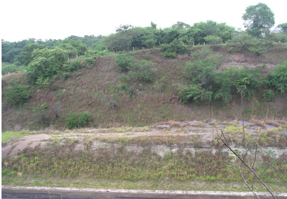
Figura 5: Vista geral do afloramento do km 164 da SP280.
