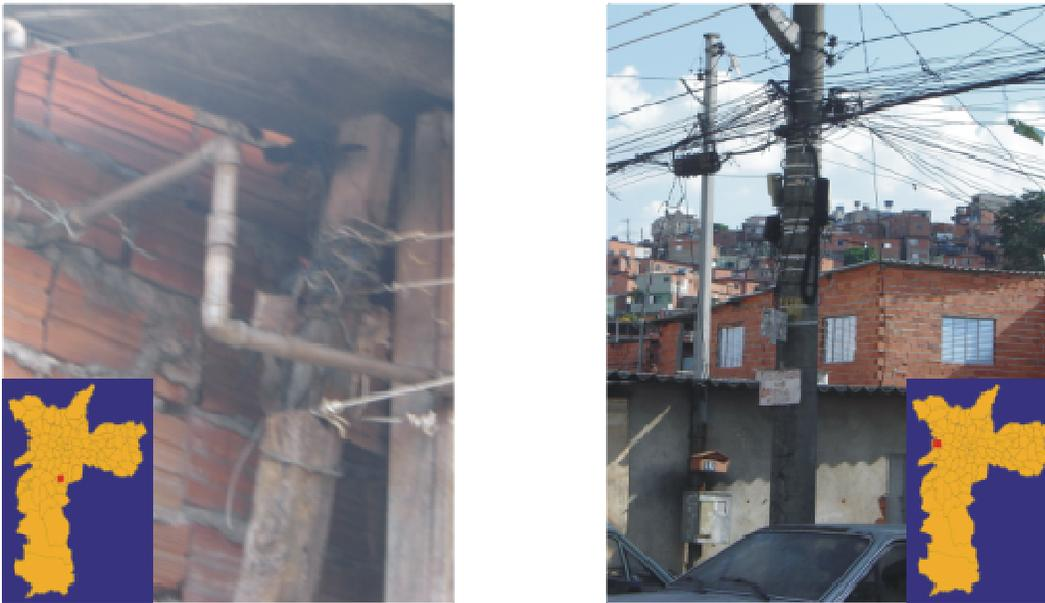
**Figura 4.19** – Na primeira foto há canos que distribuem água para as residências. Durante a visita, foi possível visualizar marcas de gordura deixada pelos ratos. A segunda foto mostra grande quantidade de ligações clandestinas de eletricidade. Os “gatos” também servem como locomoção para os ratos, permitindo um melhor deslocamento entre as residências. Foto tirada no dia 26 de março de 2007.
