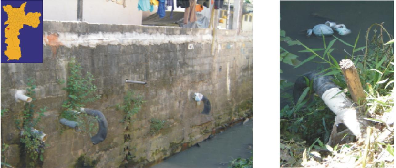
**Figura 4.18** – Canos protegidos com câmaras de pneu para impedir a entrada de animais durante as cheias. Altura da proteção sugere o nível das águas durante uma enchente. Foto tirada no dia 26 de março de 2007.
