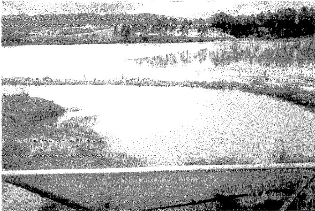
**Foto 2.** Tanque de decantação da Cessi Comércio de Materiais para Construção Ltda, construído sobre cava de extração desativada (Foto cedida por PRESTES. P. M. Maio de 2004).
