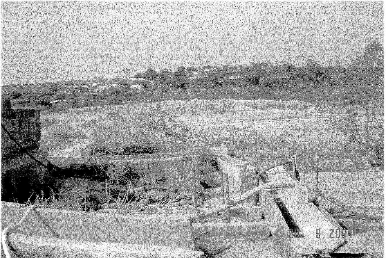
**Foto 4:** Recuperação do tanque de decantação da Justo Extração de Areia Ltda. que, após o esgotamento, passará por processo de secagem para que possa receber compactação, cobertura de solo orgânico e plantio de gramíneas. (Foto da autora, Setembro de 2004).
