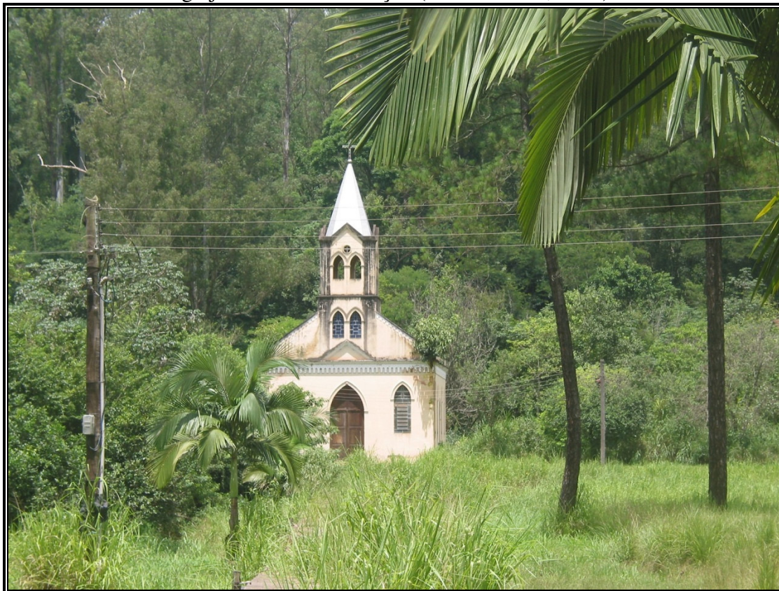
Foto 8: Rio Claro: Floresta Estadual Edmundo Navarro de Andrade - Vista da passarela e Igreja antes da restauração (Foto: Joinhas, 2005).
