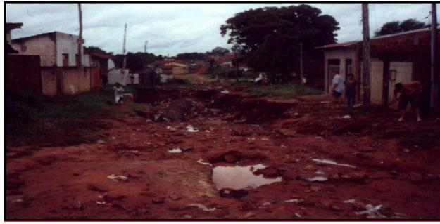
Foto 4.4. Loteamento anterior a 1979 com casas construídas no talvegue.
