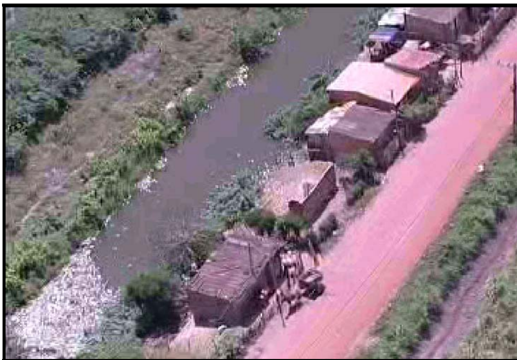
Foto 7.3 - Trecho em área urbana do canal Coqueiro (Tecnorte 2001).
