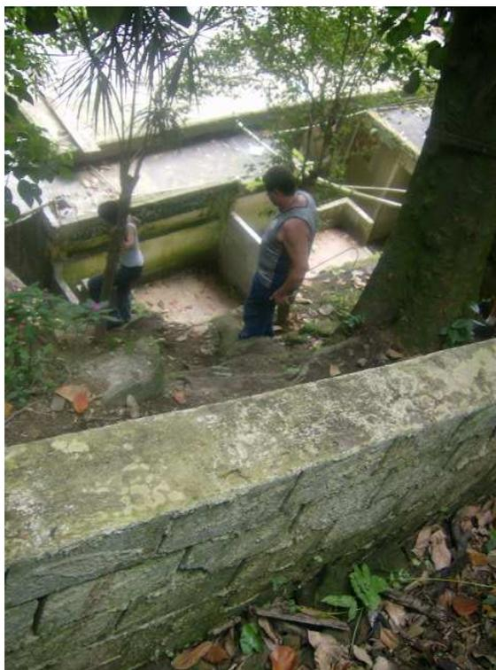
Foto 5. 18 – Muro de proteção construído no Morro do Itararé como medida de contenção a movimentos de massa.
