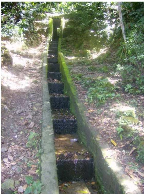
Foto 5. 19 – Canaletas pré-moldadas construída no Morro dos Barbosas.
