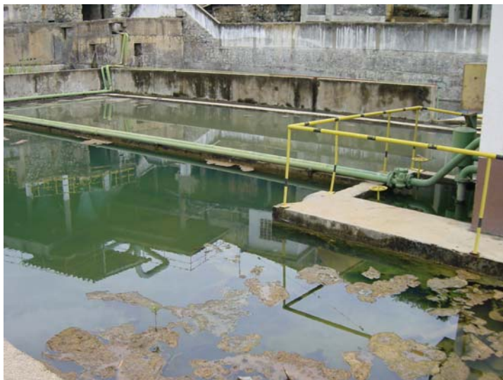
Figura 3.6: Vista da estação de tratamento de efluentes da usina Plumbum S.A., localizada em frente a antiga usina (ao fundo), às margens da principal estrada da Vila Mota.
