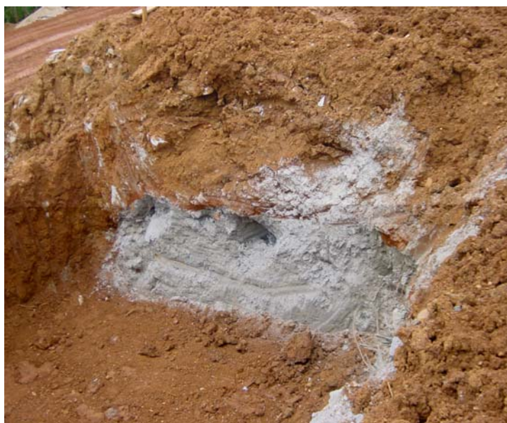
Figura 1.5: Vista da bacia de contenção de rejeito de minério da mina do Rocha, para isolar os materiais ricos em chumbo. O material acinzentado é o rejeito rico em chumbo, já recoberto com a camada de solo rico em argilominerais. A profundidade da vala é de aproximadamente 5 metros.
