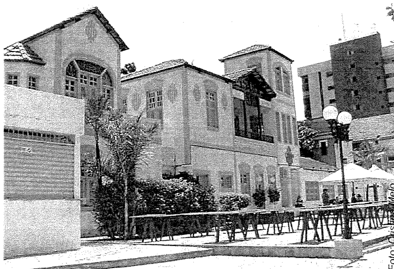
FIGURA 11- Vista frontal do Restaurante Estoril em 2002.
