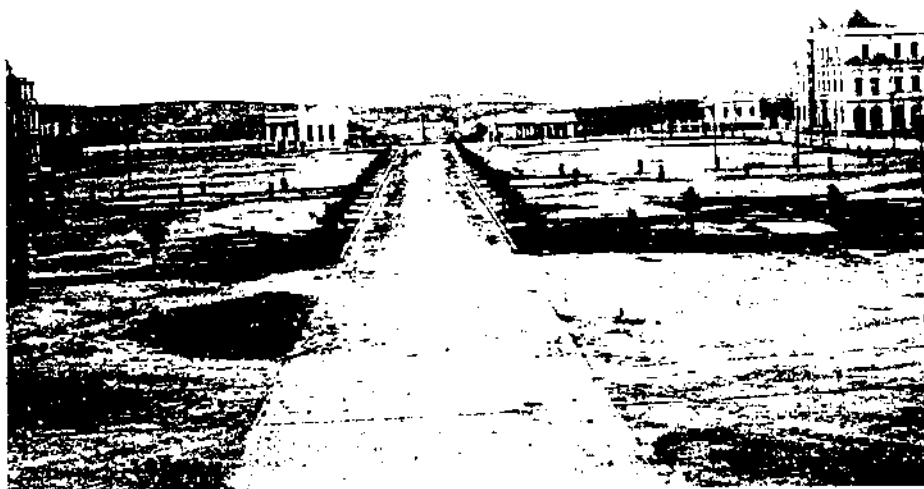
PRAÇA DA LIBERDADE EM CONSTRUÇÃO
