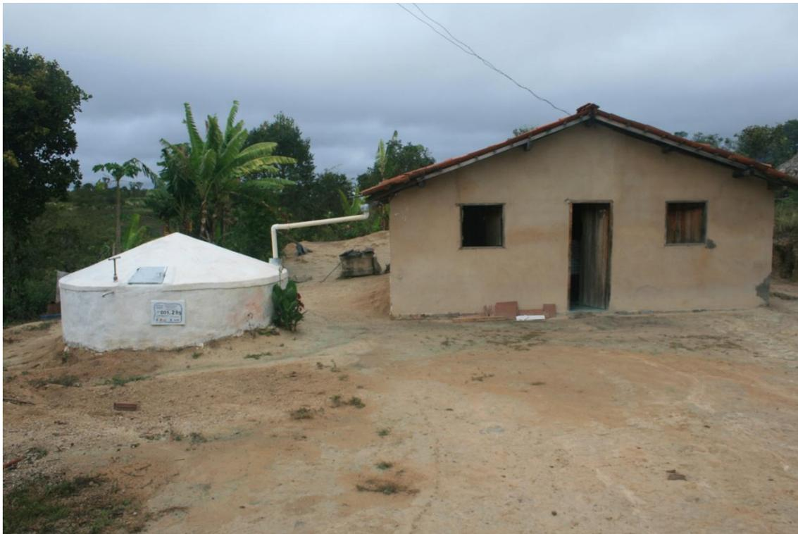
Foto 13. Cisterna caseira (16 mil L) de captação de água da chuva, construída pelo programa P1MC (localidade Boa Vista). Autor: Igor SHC.
