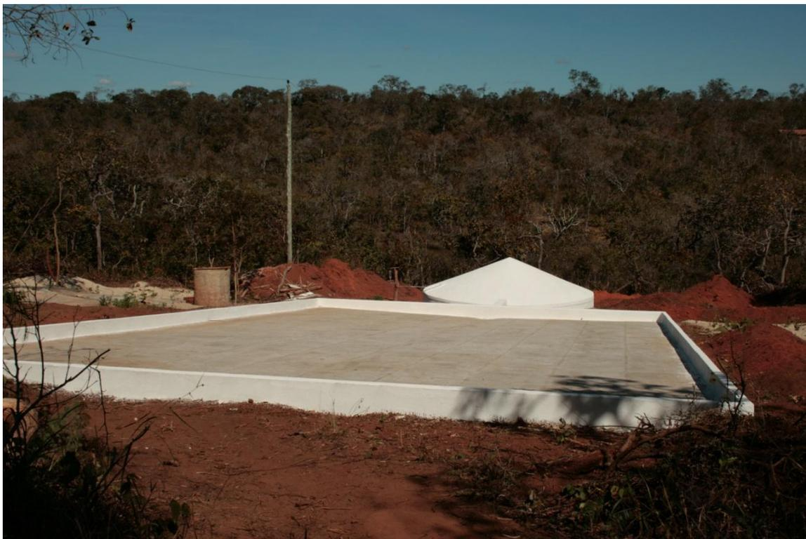
Foto 14. Cisterna calçadão (52 mil L) de captação de água da chuva, construída pelo programa P1+2 (localidade Boa Vista). Autor: Igor SHC.
