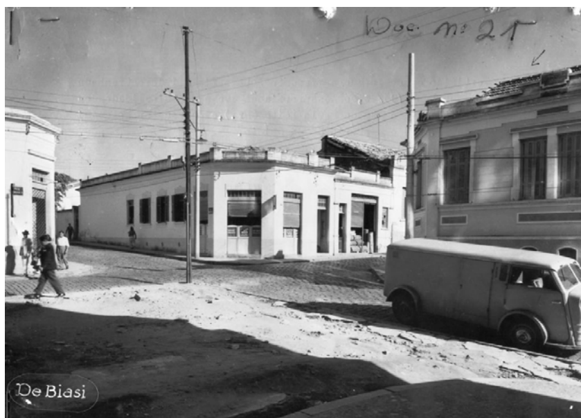
Fig. 22 - Alargamento parcial da rua Campos Sales. No canto inferior esquerdo observa-se um terreno desapropriado, no canto inferior direito vê-se a nova guia.
