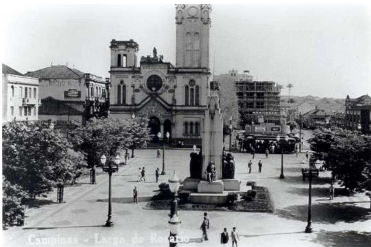
Fig. 23 - Largo do Rosário na década de 1940. Observa-se a Igreja do Rosário ao fundo e, atrás dela, o edifício do Fórum já em construção.
