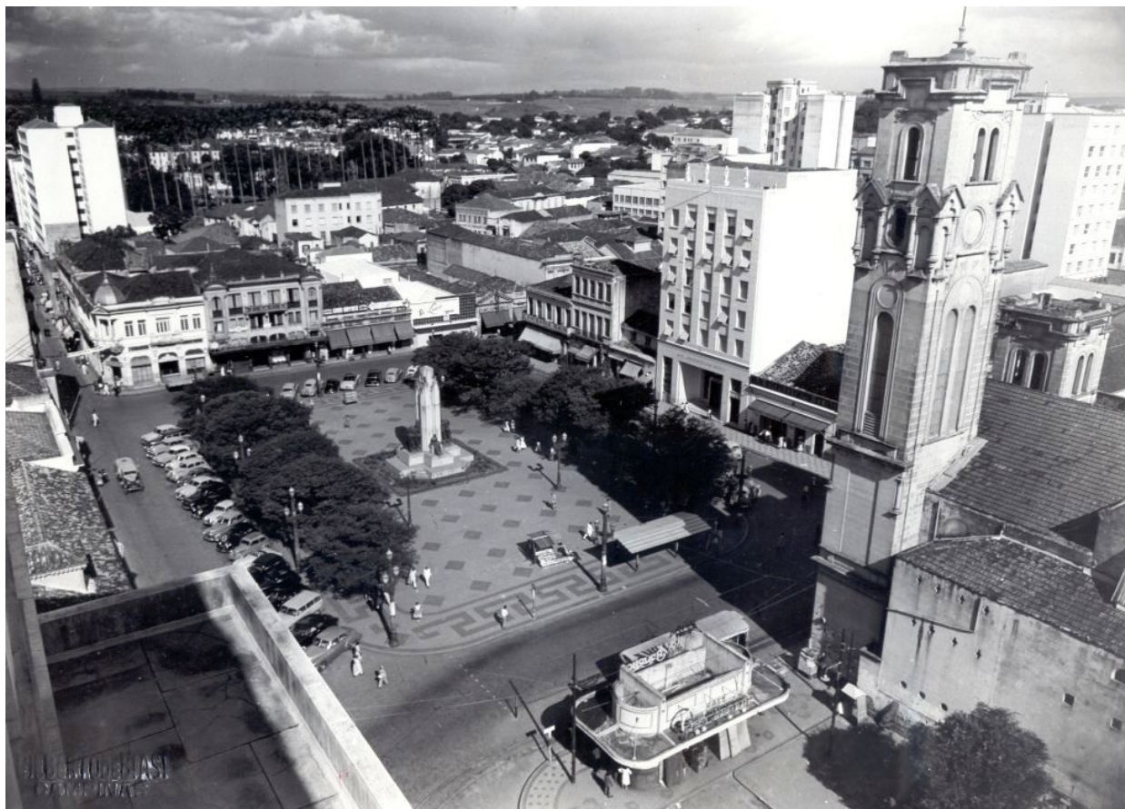
Fig. 20 - Largo do Rosário e torre da antiga Igreja vistos de cima. As demolições ocorreriam em toda extensão da rua Francisco Glicério.
