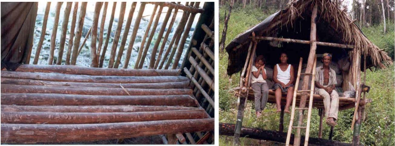
Para o armazenamento final, foi erguida uma tarimba coberta (figura 15 à direita), armação com quatro paus fincados no chão, cuja parte superior tem forma de forquilha. Em cada par de forquilhas é encaixado um pau, que serve como
