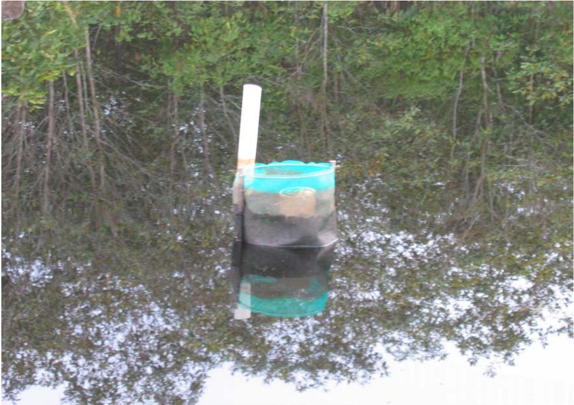
**Imagem 13 - Estrutura de cachimbo, que permite o escoamento da água mas veda a passagem aos peixes. Em volta do tubo, artefato construído na estação de piscicultura, que impede a fuga dos peixes, conhecido como “filtro”. (foto do autor)**
