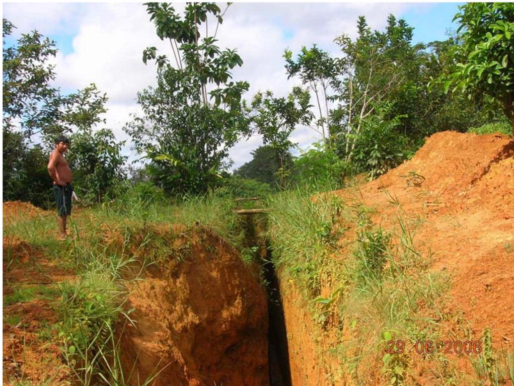
**Imagem 08 – Arlindo Maia, apresentando o resultado dos trabalhos de escavação manual para instalação da tubulação de abastecimento de água, até o laboratório da estação de piscicultura de Iauaretê. (foto do autor)**
