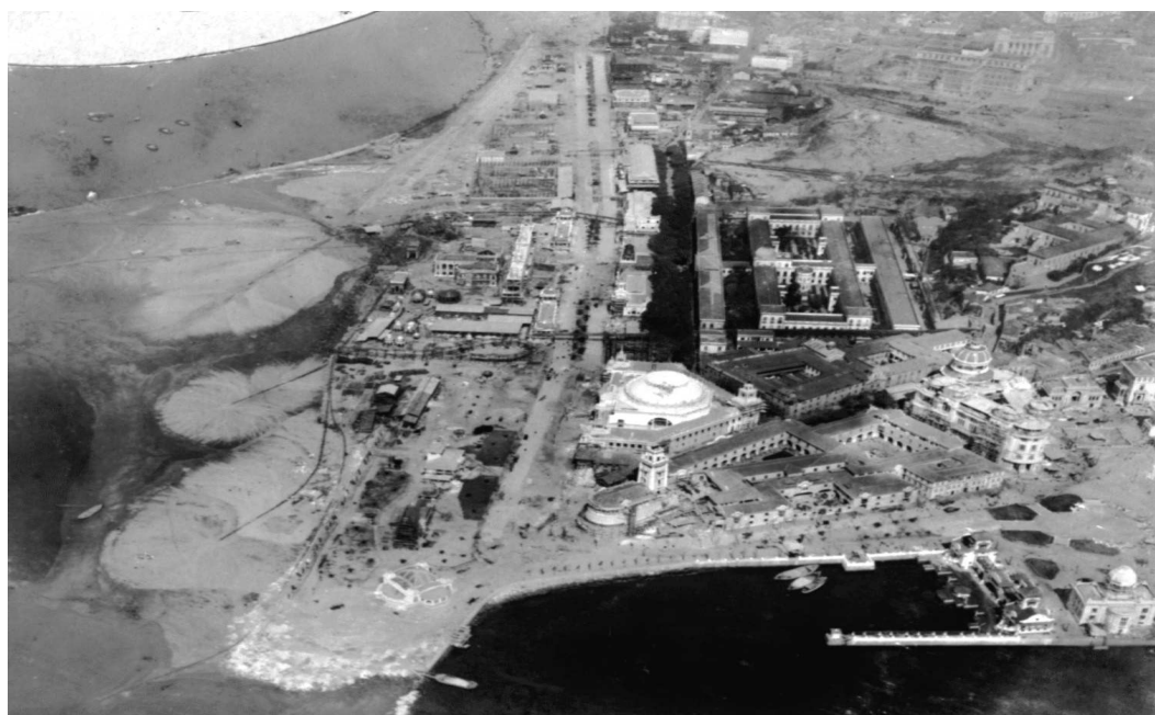
(Praia de Santa Luzia aterrada; pavilhões sendo construídos, vista aérea da ponta da exposição, Jorge Kfuri, SDM)
