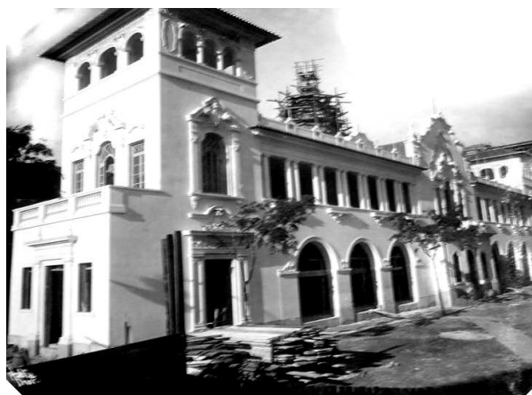
(Pavilhão das Pequenas Indústrias em construção, Malta, 15 de maio de 1922, MHN)
