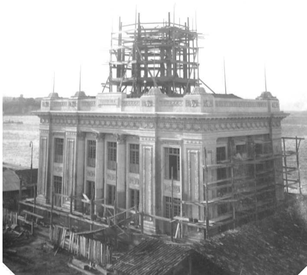
(Pavilhão da Estatística em construção, Malta, 15 de maio de 1922, MHN)
