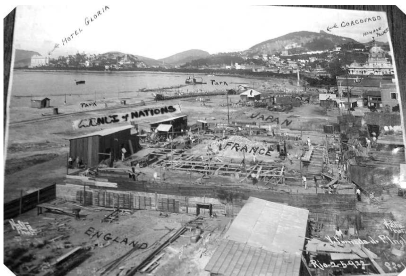
(V. Tomada do pavilhão Inglês, Canteiro de obras na Avenida das Nações, Malta, 2 de maio de 1922, MHN)
