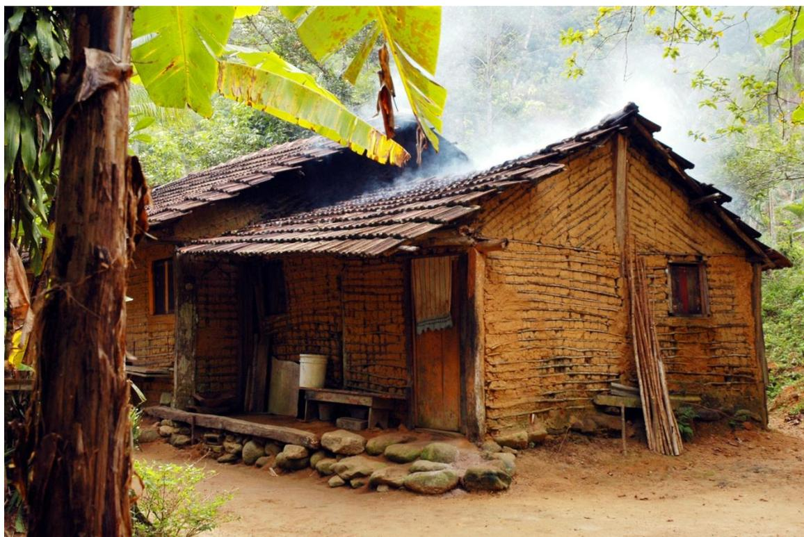
Figura 12. Casa de pau a pique no Camburi. Hoje restam poucas habitações construídas com essa técnica e as ainda existentes estão progressivamente sendo substituídas por alvenaria. Os telhados, agora industrializados, eram feitos de sapé e palha de uricanga, uma palmeira nativa. Foto: A. Arantes.
