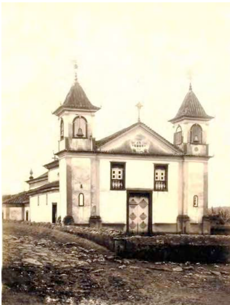
Figura 7 - Adro da Igreja Matriz em 1894. Fonte: APCBH.
