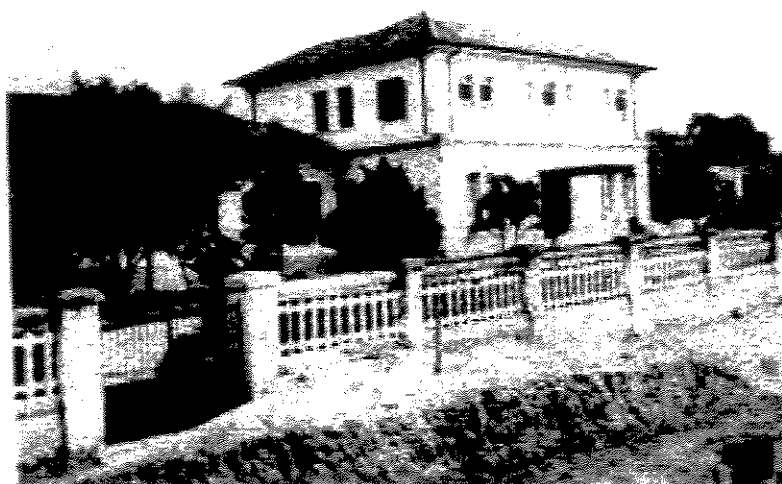
Santa Casa de Misericórdia de São José dos Campos, na década de 40. Instalação da rede de água e esgoto. 49
