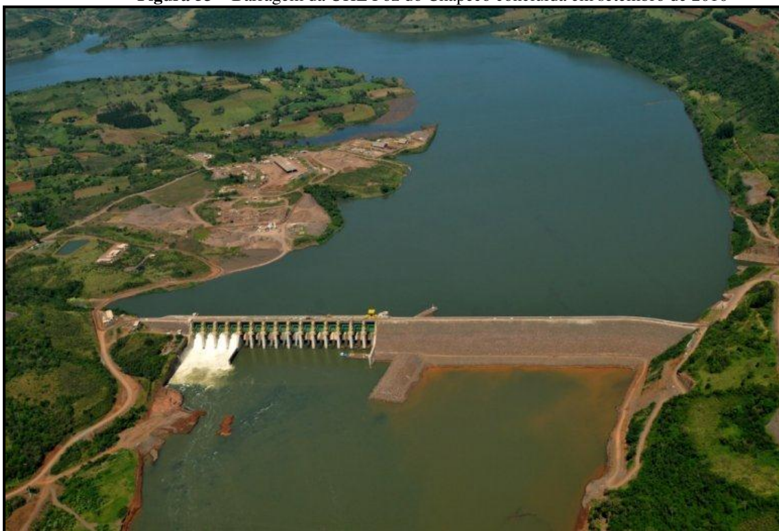
Figura 53 – Barragem da UHE Foz do Chapecó concluída em setembro de 2010
