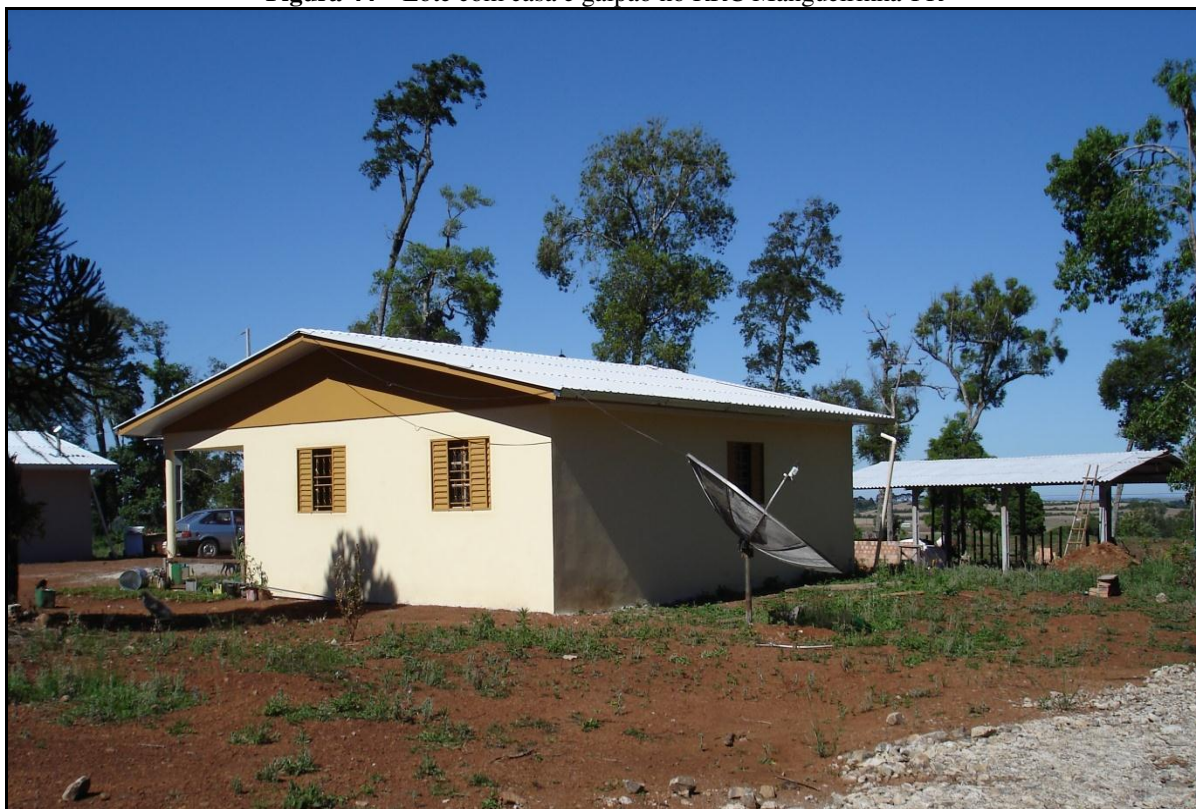
Figura 44 – Lote com casa e galpão no RRC Mangueirinha-PR
