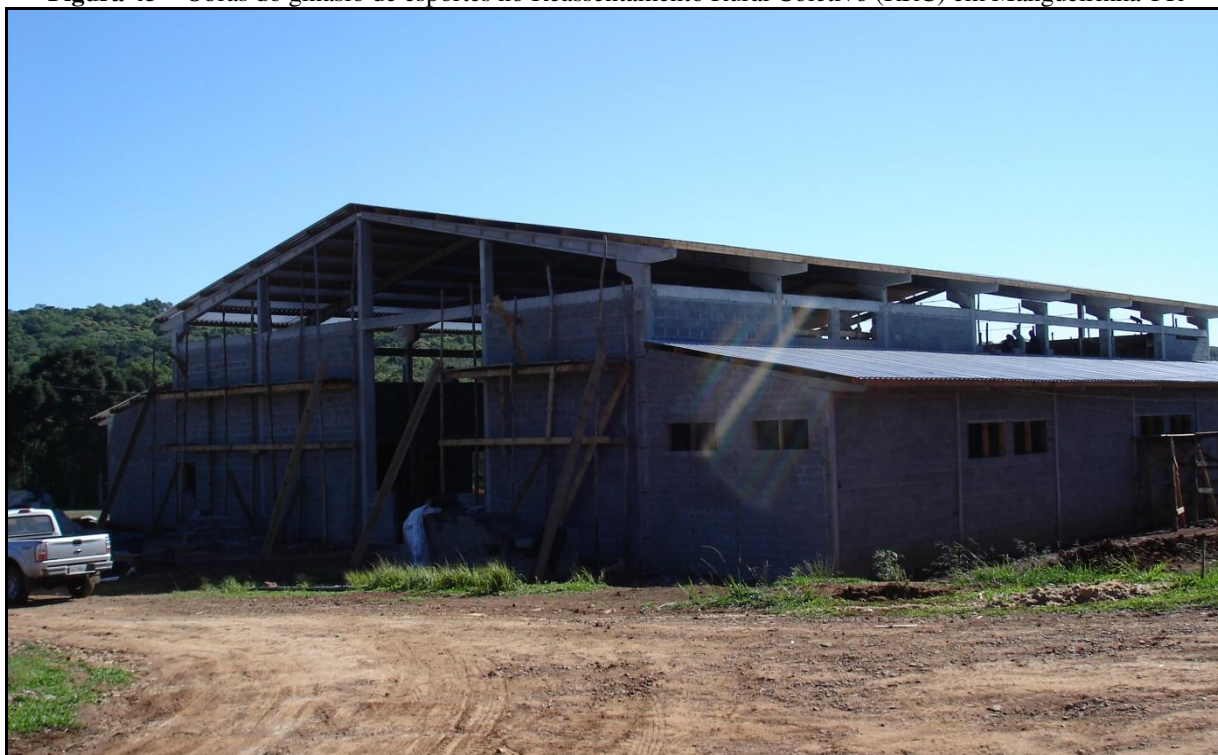
Figura 45 – Obras do ginásio de esportes no Reassentamento Rural Coletivo (RRC) em Mangueirinha-PR
