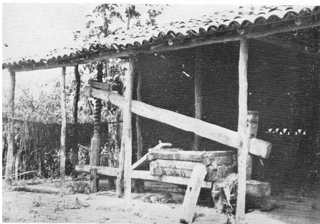
Fig. 21 - Prensa de viga : fotografia de uma prensa de viga em forma quase inalterada, então ainda em uso. Ceará, meados do século XX.
