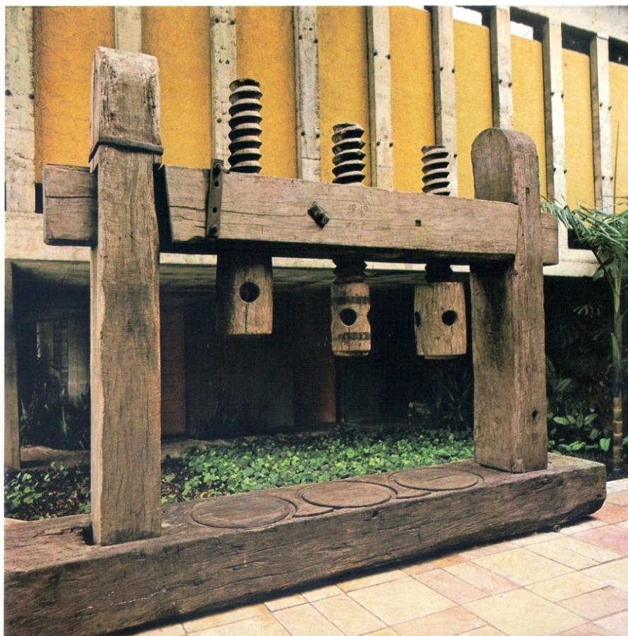
Fig. 27 - Fusos multiplicados : Prensa de três fusos outrora em uso em São Paulo, século XIX.
