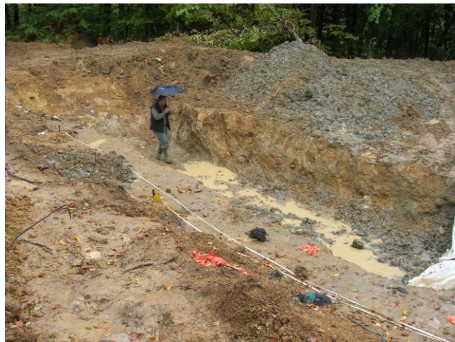
Escavações - vala comum
