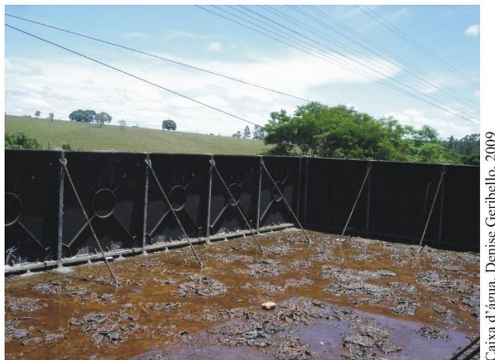
**Figura 36. Acúmulo de lodo no reservatório**
