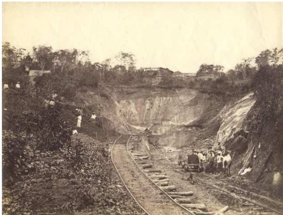
Figura I – Trabalhadores da construção de um corte da linha férrea
