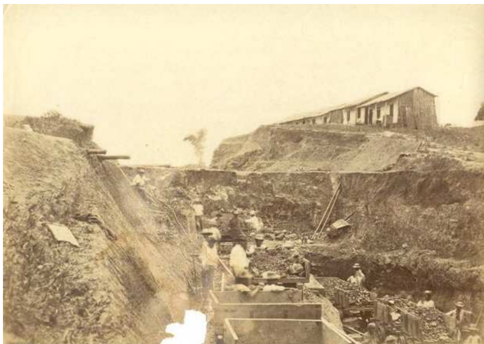
Figura II -Trabalhadores construindo a base de uma ponte
