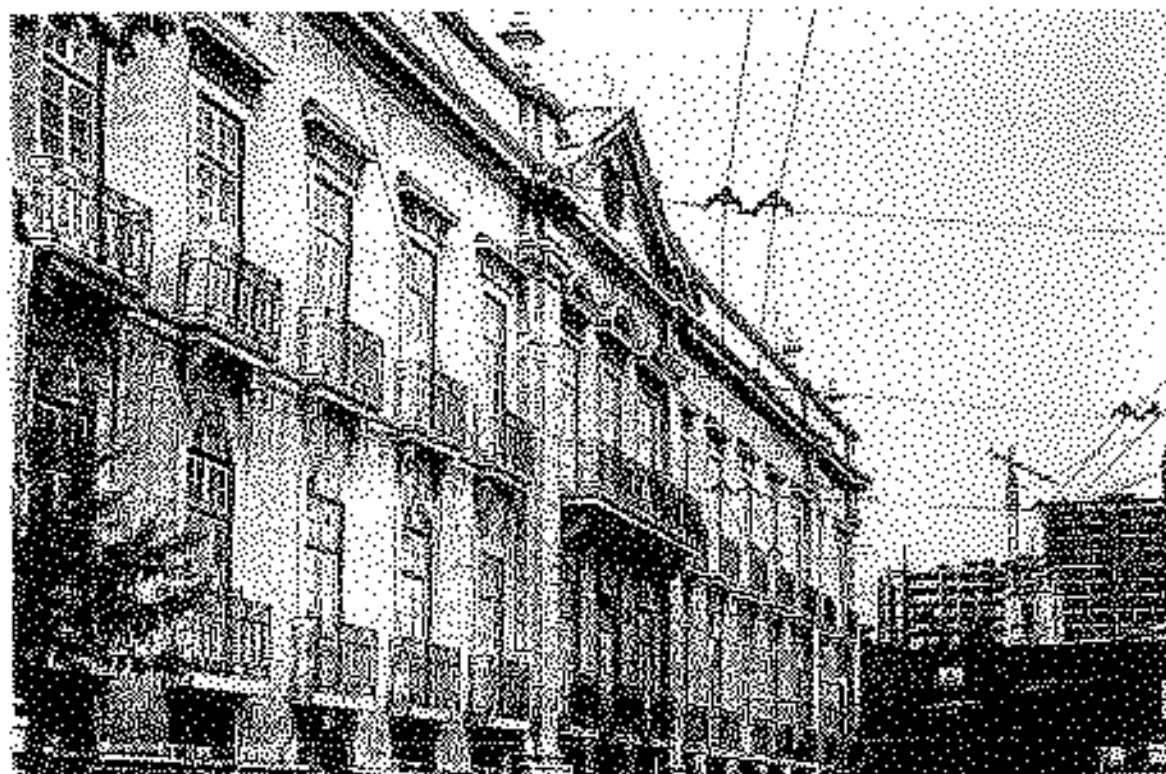
Il. 32. Palácio União - Nisa -- reconstruído em 1740
