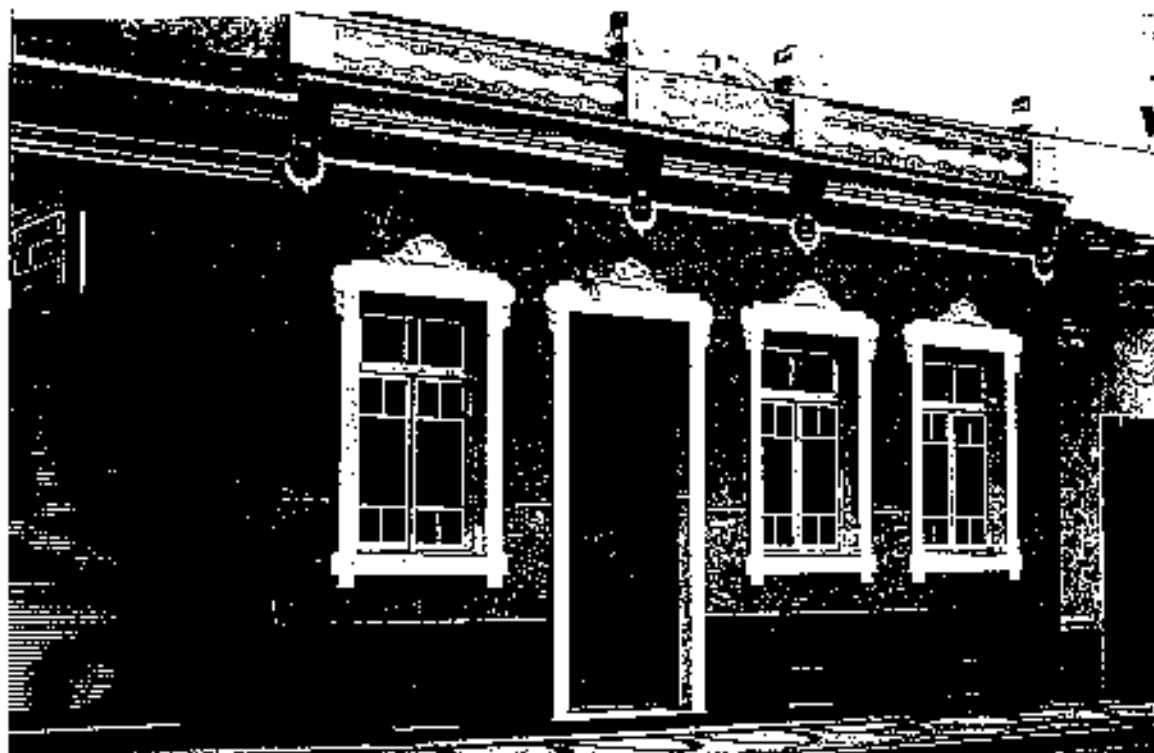
II. 132. Residência dos Maia – Rua 15 de novembro – Amparo
