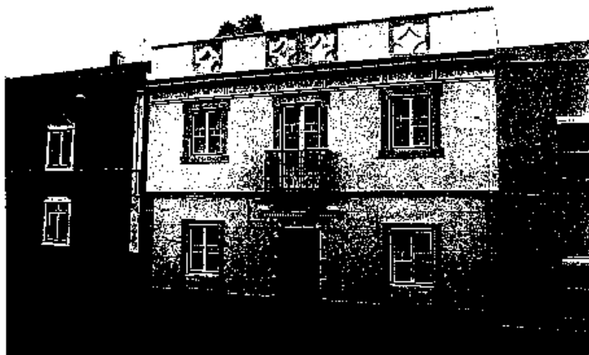
Il. 1779. Rua Engenheiro Duarte Pacheco, 13 – (19)
