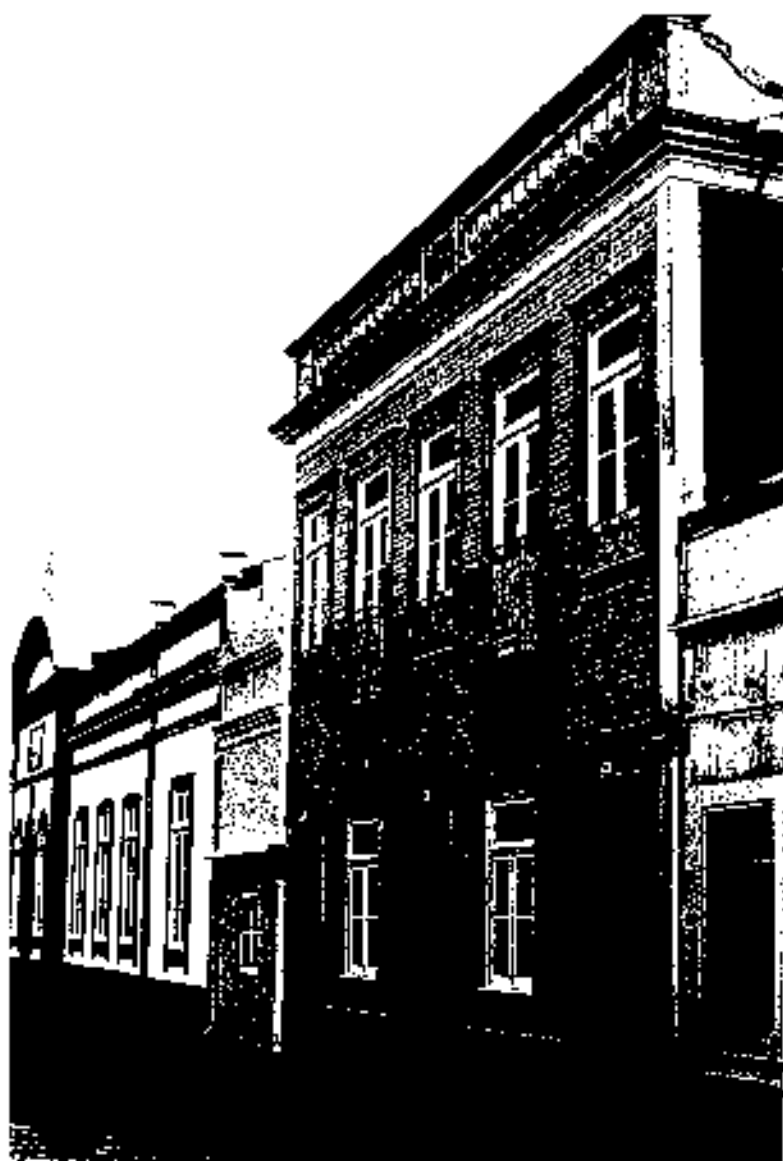
Il. 1732. Rua Antônio José Freitas Guimarães. 13/13 A /13B
