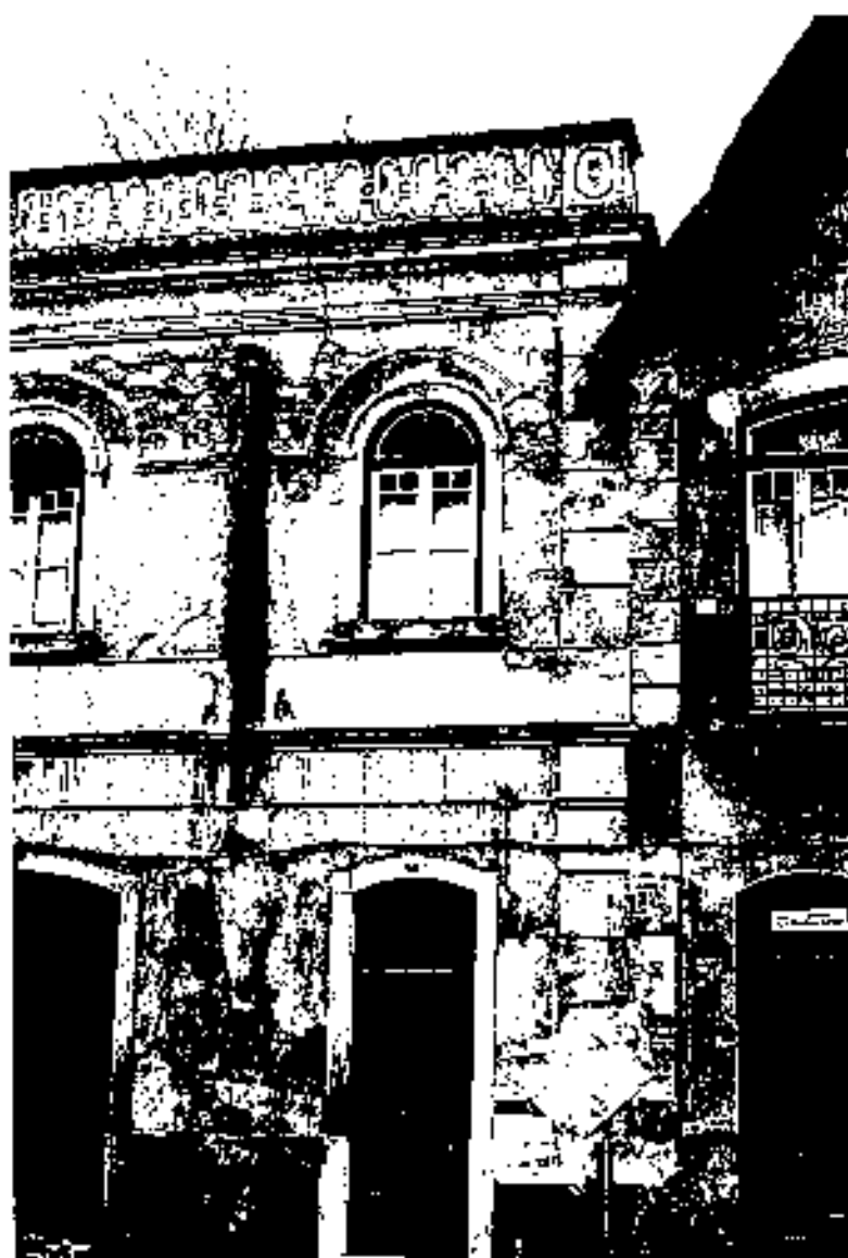
Il. 1792. Edifício nº 64/69 (detalhe)
