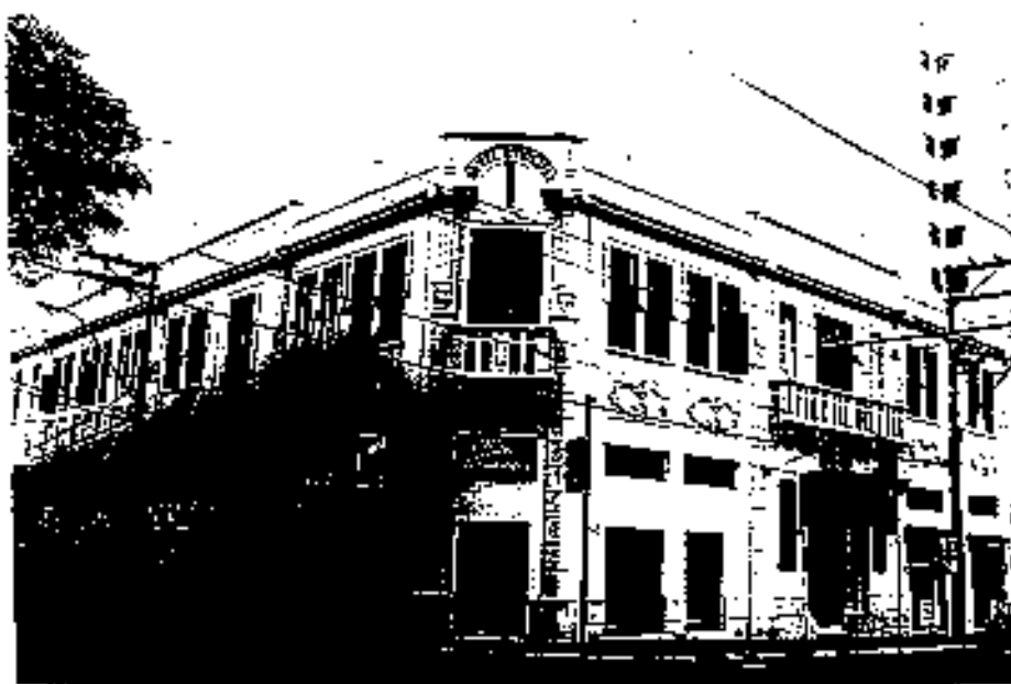
II. 653. Rua São Bento, 742
