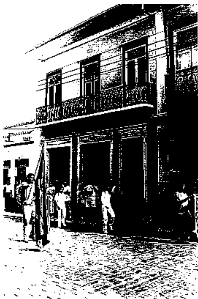
Il. 741. Rua Manoel de Aguiar, 90 (1862)
