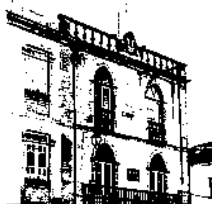
Il. 403. Batalha (Portugal) Praça do Convento, 6
