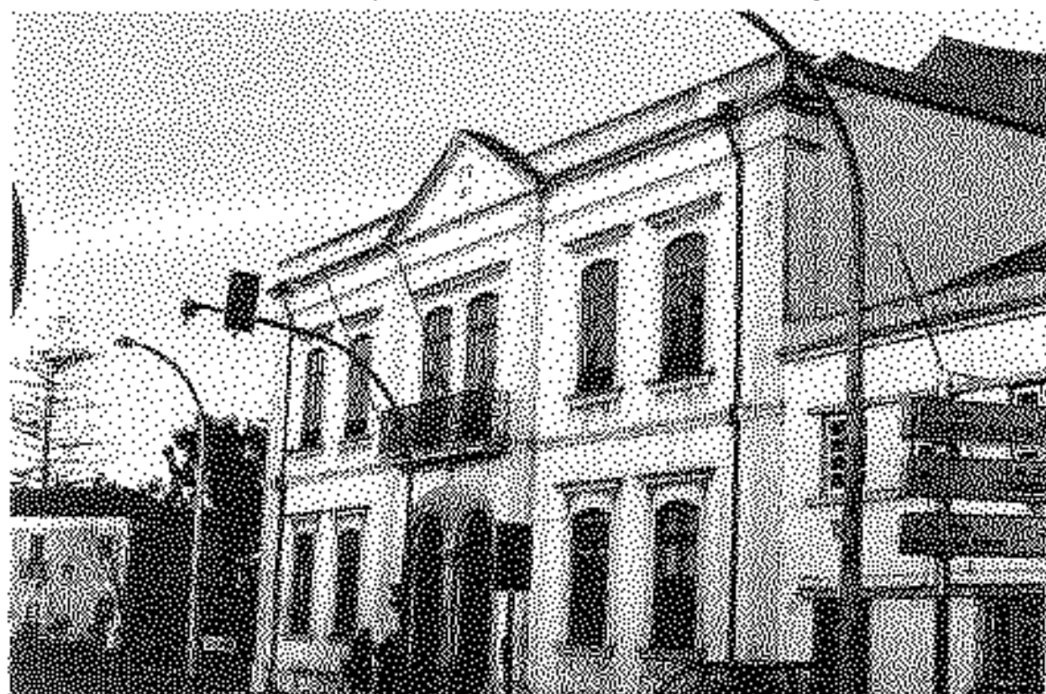
Il. 39 -- prédio em Mira (1917) Portugal
