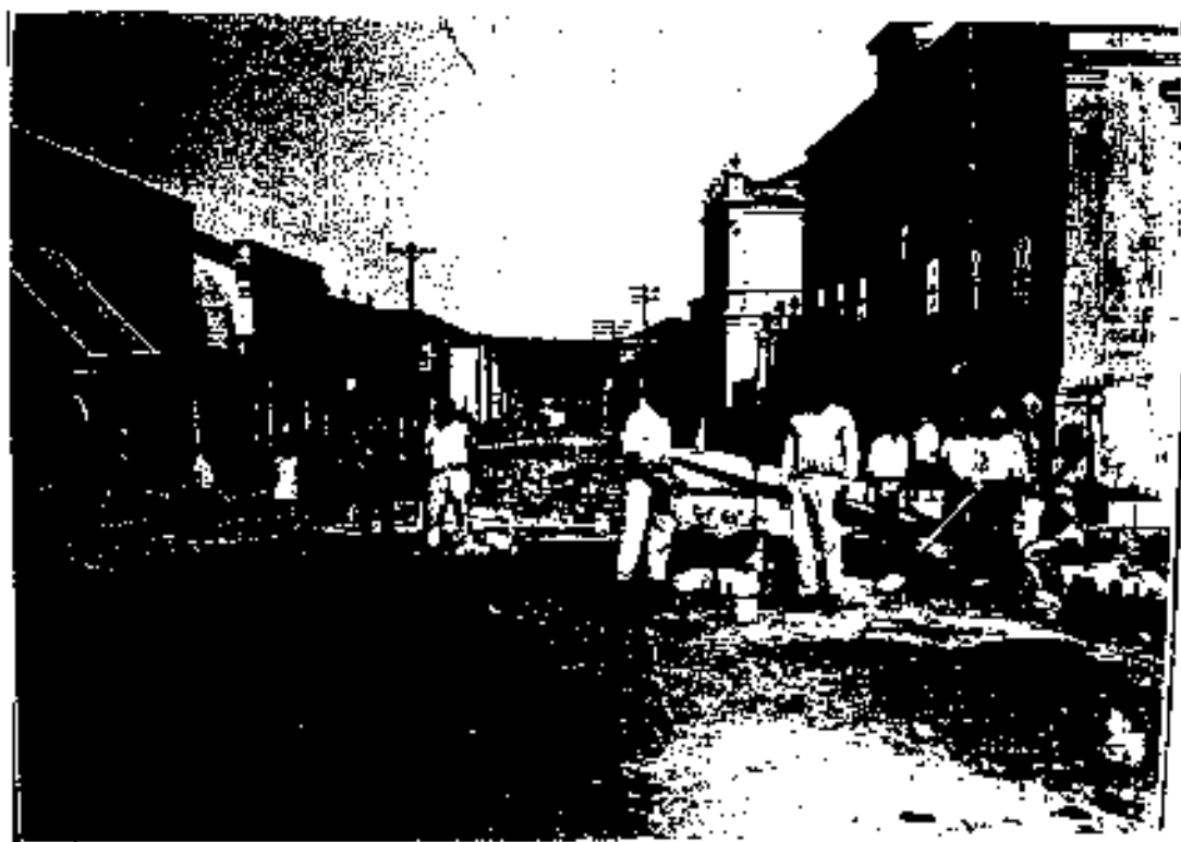
Il. 944. Rua Barão do Rio Branco
