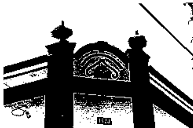
Il. 379. Itapetininga Rua Saldanha Marinho, s/n (detalhe)
