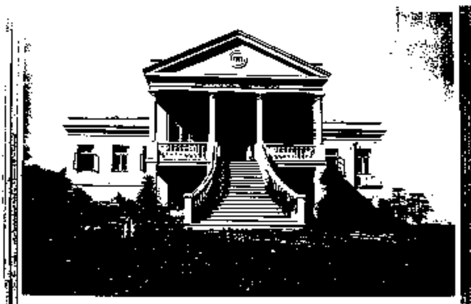
II. 143. Edifício do antigo Asilo de Mendigos - Amparo
