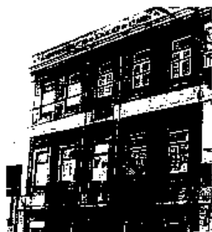
Il. 554. Lisboa (Portugal) Rua da Junqueira, 253
