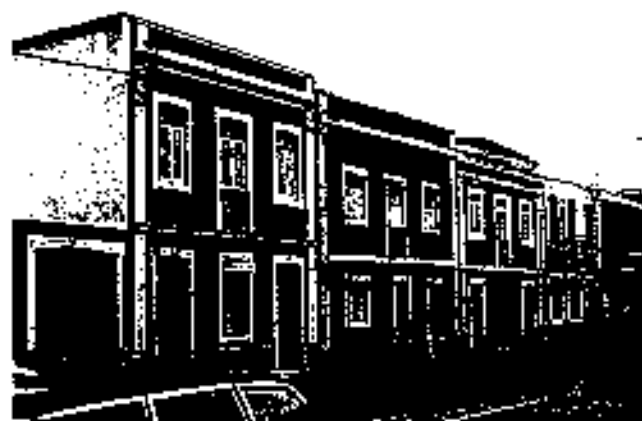
II. 498. Figueira da Foz (Portugal) Rua 12 de julho, 291 a 307
