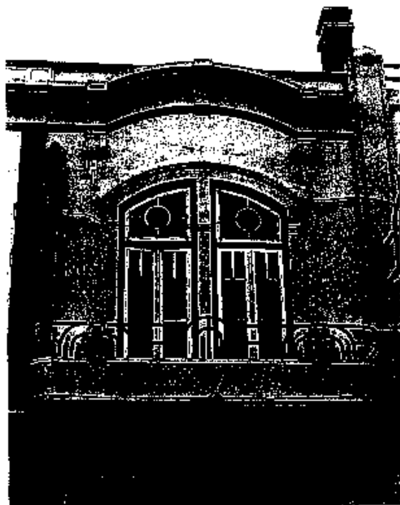
[I. 1548. Rua Marechal Gomes da Costa, 23 (detalhe)]
