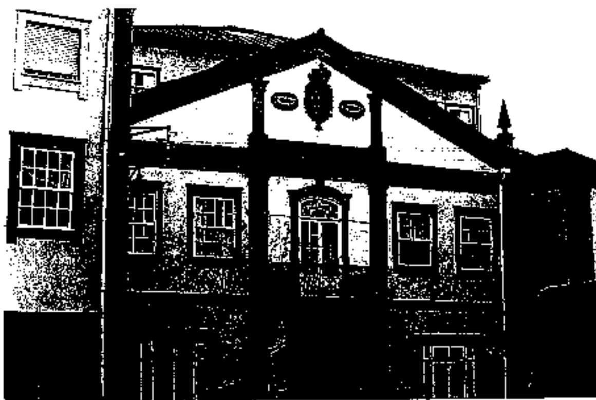
Il. 1738. Edifício do Instituto de Educação (1879)
