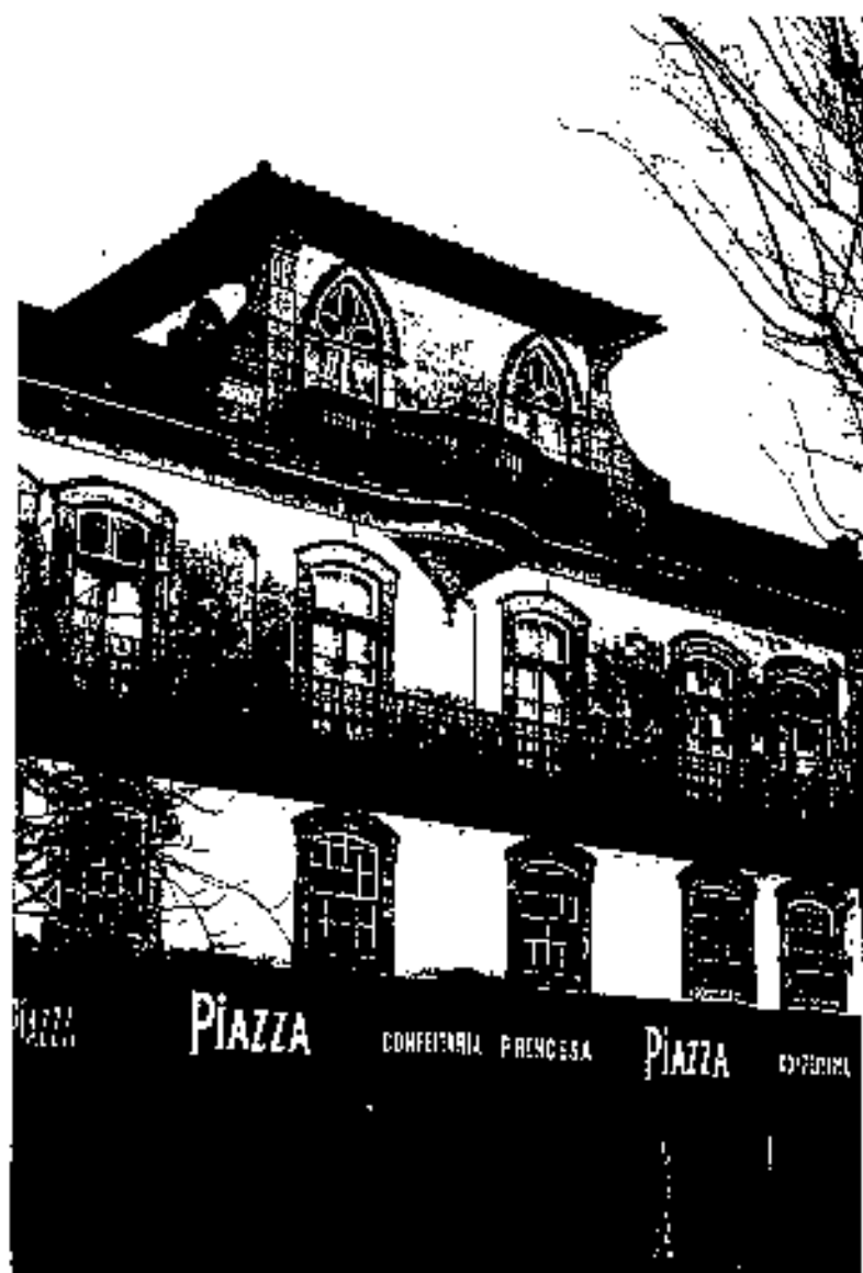
Il. 1741. Edifício s/n (detalhe)
