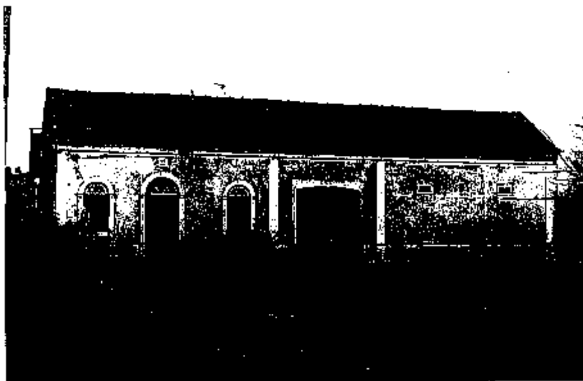
Il. 1629. Edifício s/n
