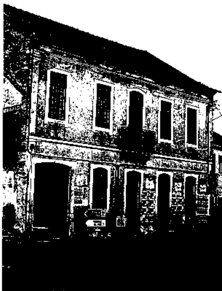
II, 1717. Edifício s/n
