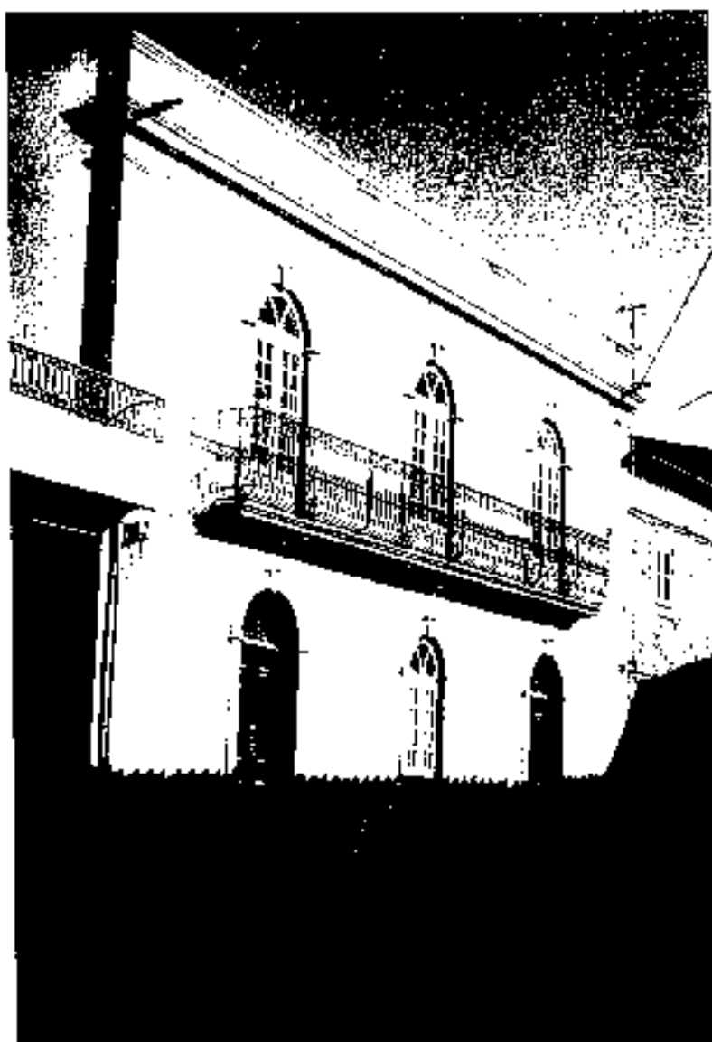
II, 1737, Edifício nº 55
