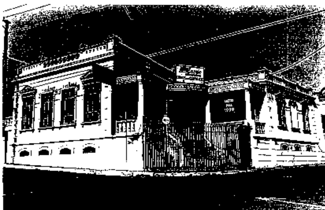
II. 992. Rua Coronel Virgílio, esquina Rua Prudente de Moraes
