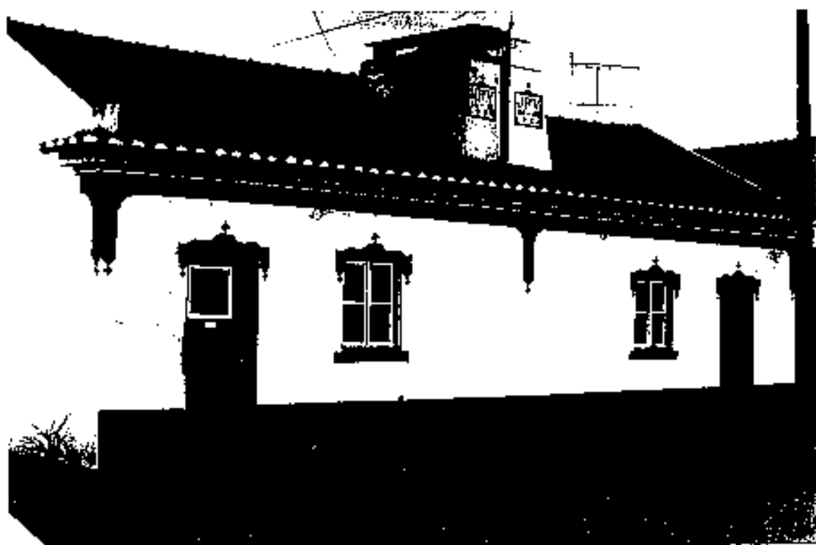
Il. 1596. Edifício s/n
