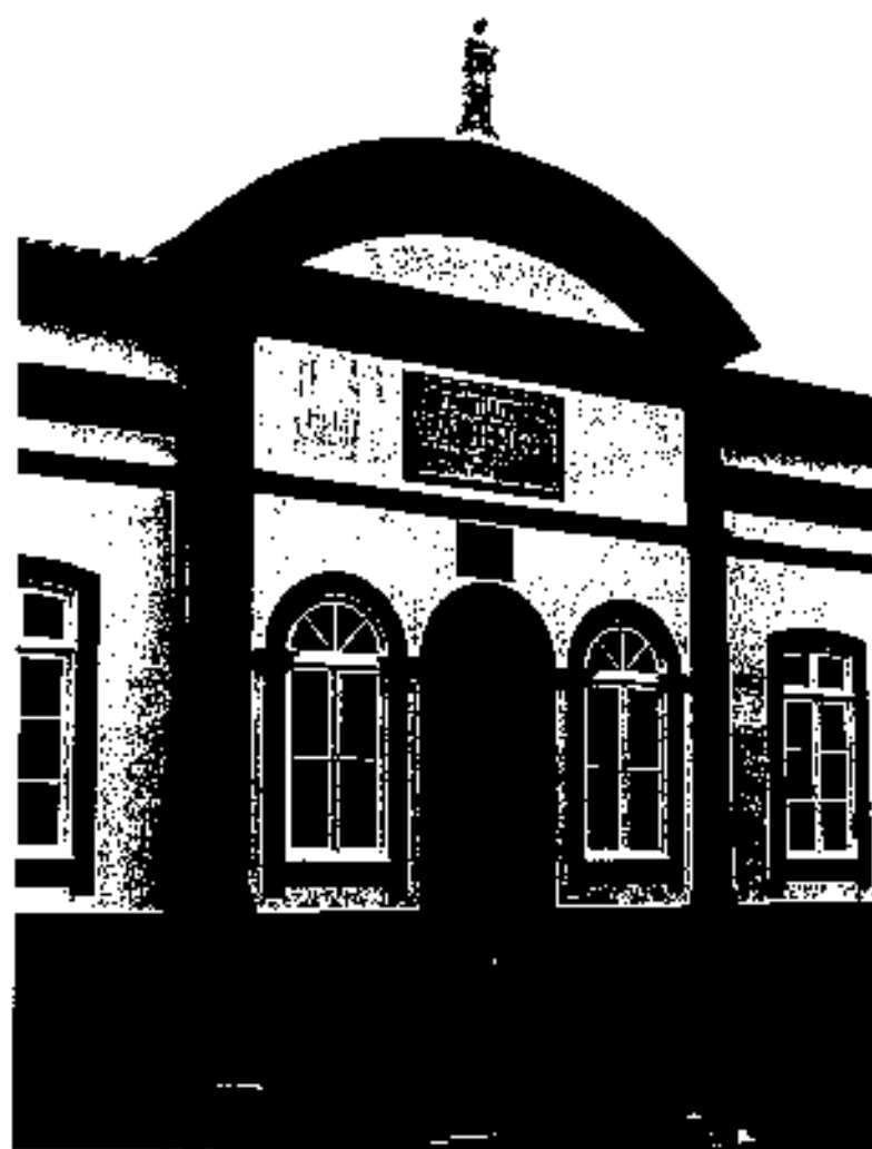
II, 1734. Edifício do Hospital-Asilo (detalhe)
