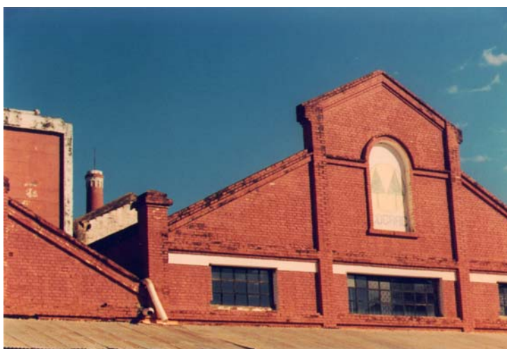
Um dos galpões da parte de trás do edifício fabril Matarazzo, com a sua janela em arco pleno vedada com alvenaria. No canto, a chaminé, construída posteriormente, na implantação da fábrica de óleo. Araçatuba, junho 2002. Foto do autor.
