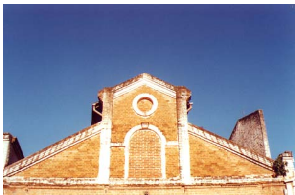
Detalhe de um dos galpões mais altos do conjunto, pela presença do óculo, acima da janela em arco pleno, totalmente vedada. Avaré, maio de 2002. Foto do autor.
