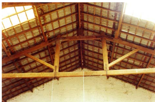
Detalhe de um modo de armação da tesoura. Itapetininga, novembro de 2003. Foto do autor.
