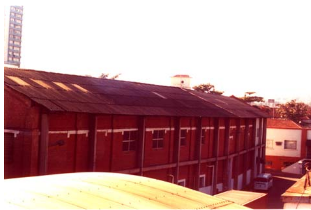
O depósito de algodão, reforçado com pilares e vigas de concreto armado. Catanduva, junho 2002. Foto do autor.
