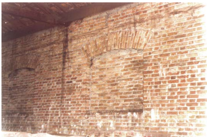
Detalhe da janela, com arco abatido em tijolos, vedada posteriormente. Bauru, novembro de 2003. Foto do autor.
