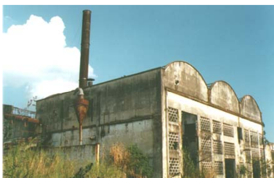
Usina termoeletrica, com planos verticais, definidos e emoldurados pelas três curvas. Campinas, abril de 2002. Foto do autor.
