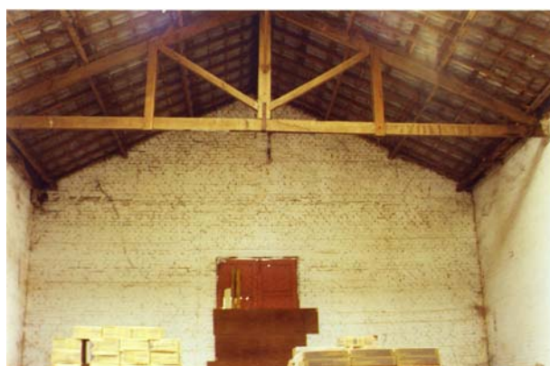
Detalhe de um outro modo de armação da tesoura. Itapetininga, novembro de 2003. Foto do autor.
