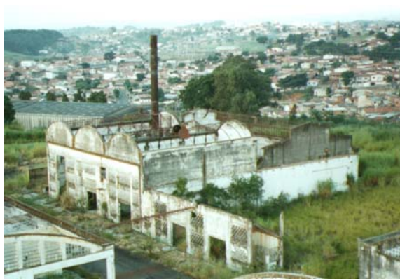
Vista aérea da usina termoeletrica. Campinas, abril 2002. Foto do autor.
