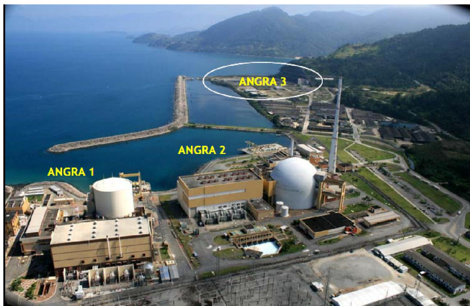
Figura 11 – A Central Nuclear Almirante Álvaro Alberto (CNAEA) com indicação do local onde está sendo construída a terceira usina (Fonte: Eletronuclear).
