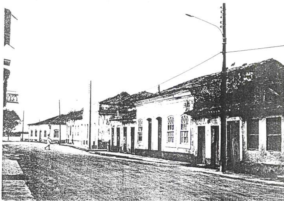
Ilustr.1: Centro histórico de Cananéia, cidade fundada no século XVI. Rua Bandeirante. Tombamento: 1969. Foto de 1972 - acervo Condephaat
