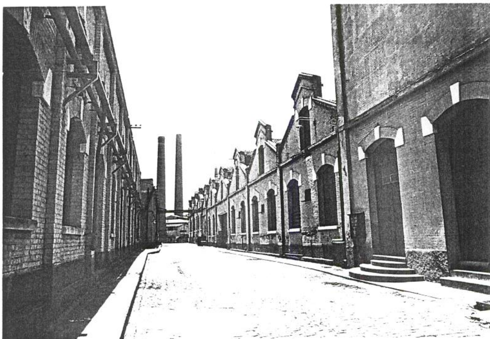
Ilustr.23: Indústrias Reunidas F.Matarazzo, na Água Branca, Capital, construção da segunda metade do século XIX, parcialmente demolida durante o processo de tombamento. Tombamento: 1986.
