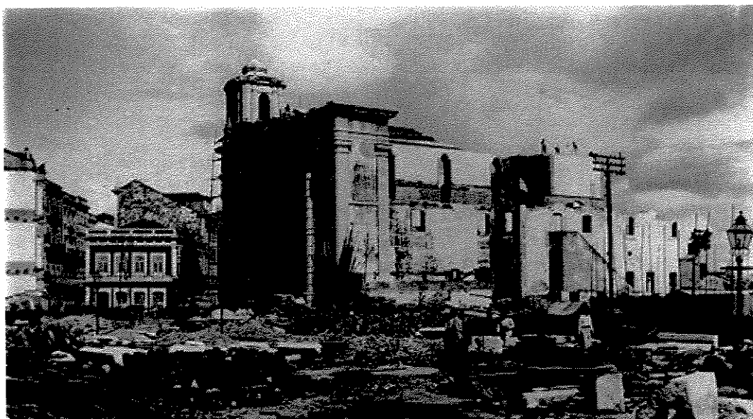
Demolição da Igreja do Corpo Santo, Recife, 1913/Coleção Benício Whatley Dias. Acervo iconográfica Fundação Joaquim Nabuco
