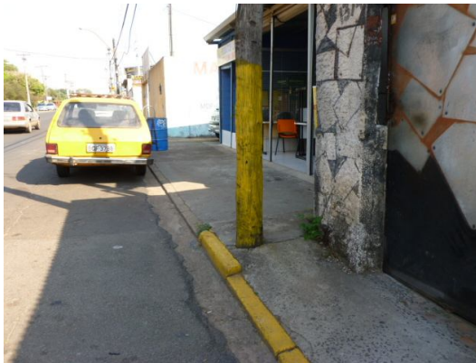
Figura 42 - Mobiliário urbano - poste de energia elétrica.
