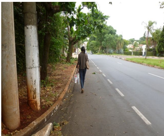
Figura 20 - Calçadas de terra.
