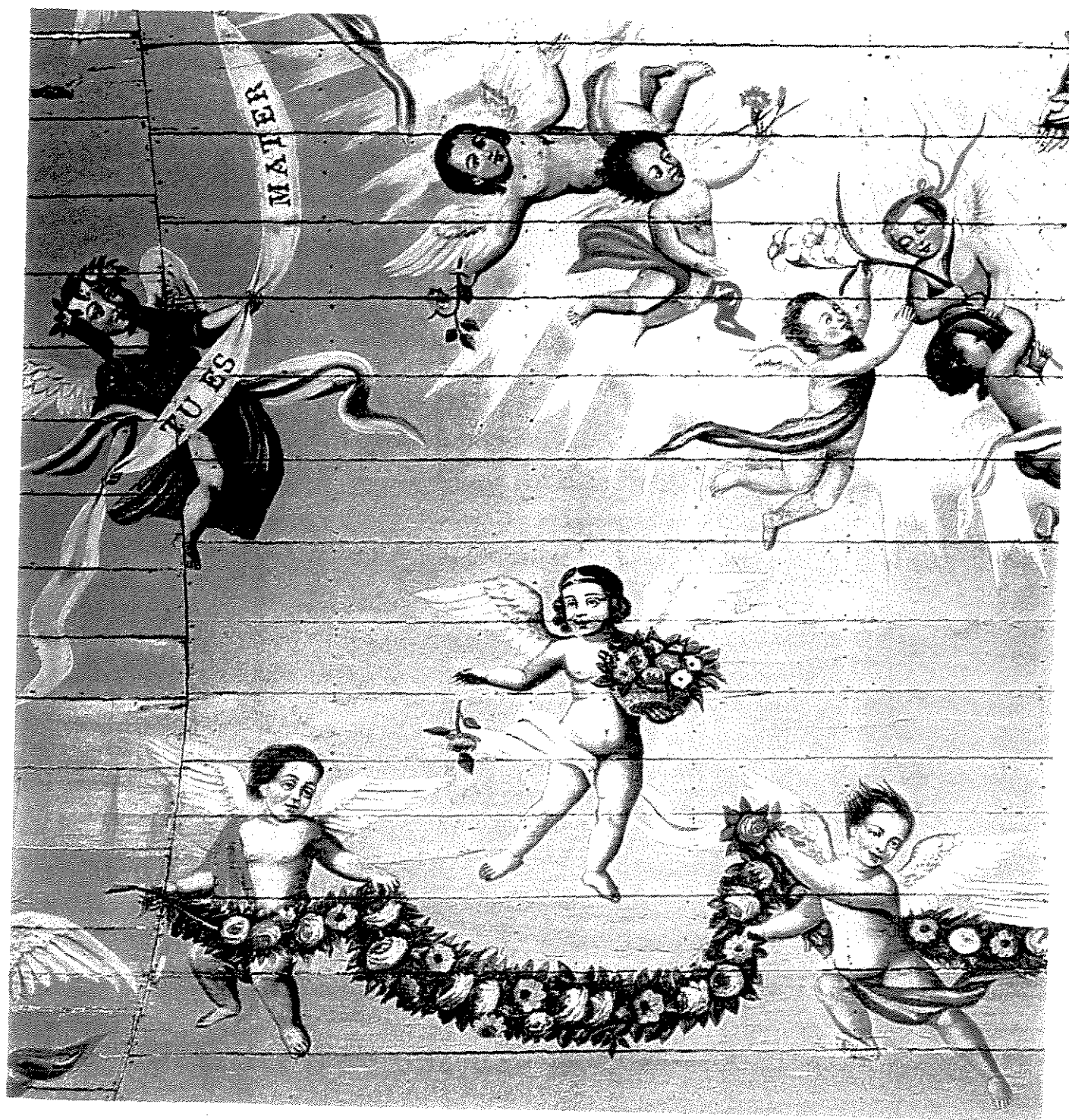
Detalhe do forro da Igreja de Nossa Senhora do Carmo de Itu
