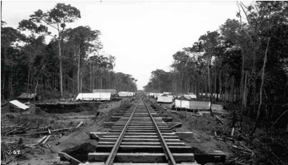
Trecho em construção da Estrada de Ferro Madeira-Mamoré
