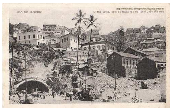
Construção do Túnel João Ricardo
