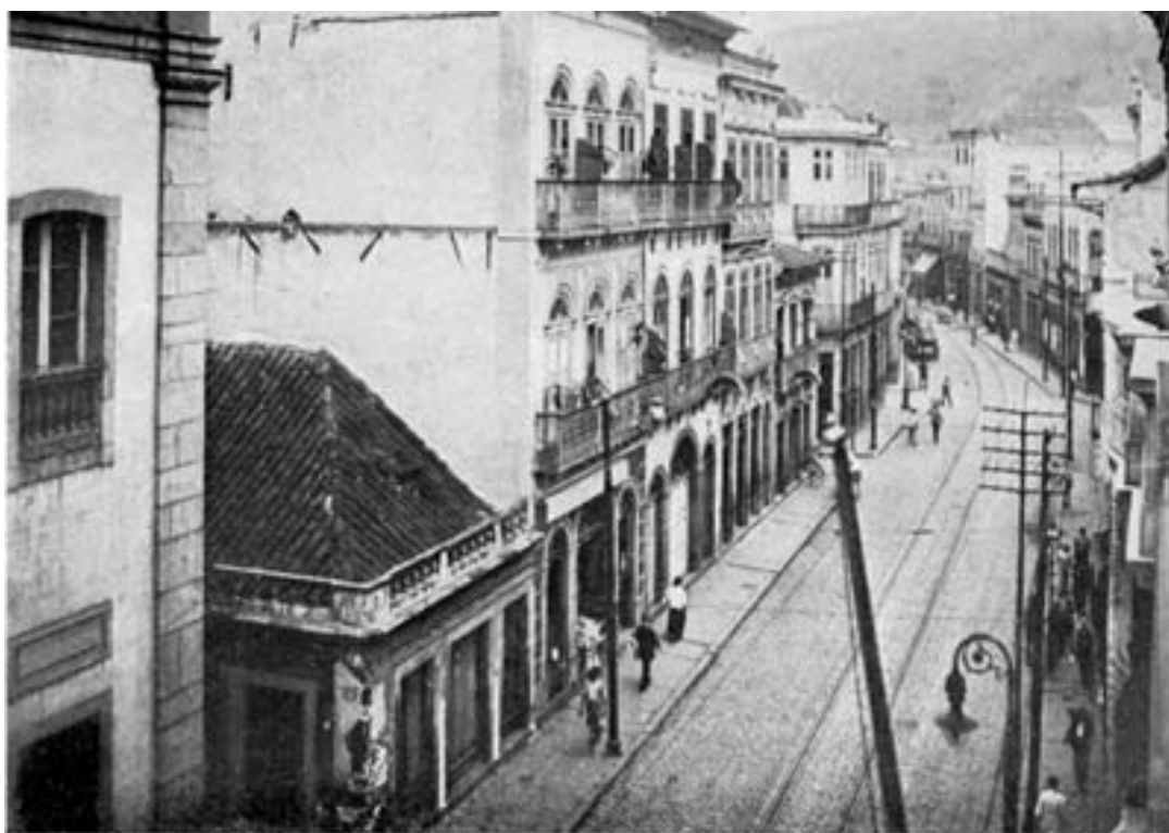
Rua da Misericórdia – Rio de Janeiro no início do século XX
