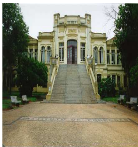
Figura 2: Entrada Principal da escola
