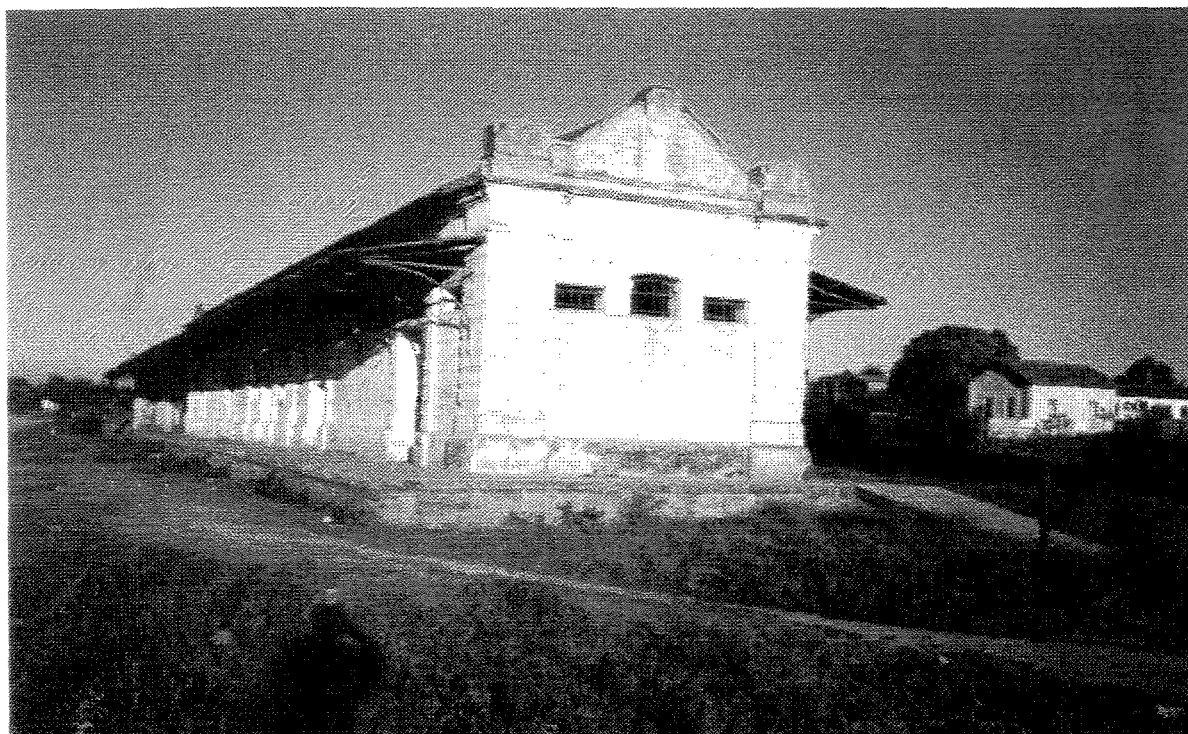
Figura 6: Estação de Buritizeiro, ponto final da Linha Centro da E.F. Central do Brasil Buritizeiro-MG, 1.006 Km do Rio de Janeiro – Inaugurada em 1926
