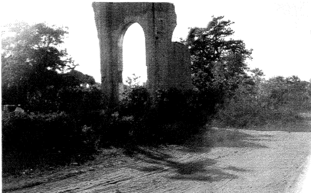
Figura 3: Ruína da Oficina de Manutenção de trens da E.F. Sobral Camocim, litoral norte do Ceará – Trecho inaugurado em 15/01/1881
