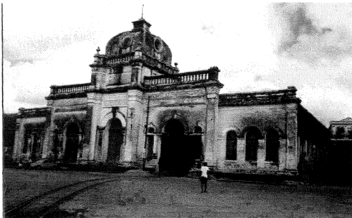
Figura 2: Estação de Cachoeira-BA Ponto inicial da E.F. Central da Bahia, trecho inaugurado em 02/12/1976.
