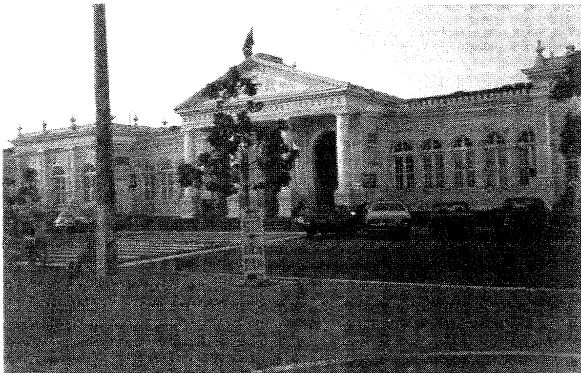
Figura 9: Estação Central de Fortaleza Prof. João Felipe, ponto inicial da E.F. Baturité Fortaleza-CE – Trecho inaugurado em 1873
