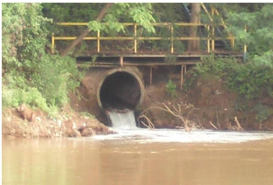
Figura 5 – Despejo de esgoto não tratado diretamente no rio Paraíba do Sul em Volta Redonda
