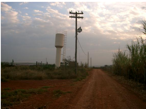
Fig. 5 – Reservatório desativado de água.
