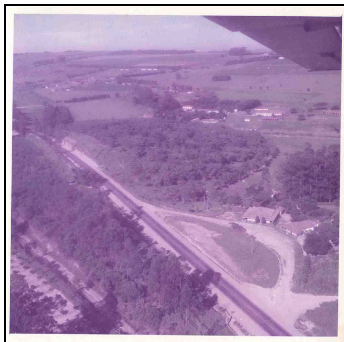
Figura 22 – Foto aérea de sobrevôo da região da Fazenda Pau D'Alho, fim da década de 1960. Vê-se a rodovia Adhemar de Barros e à direita o morro reflorestado pelos Dutilh Fonte: Acervo Dutilh
