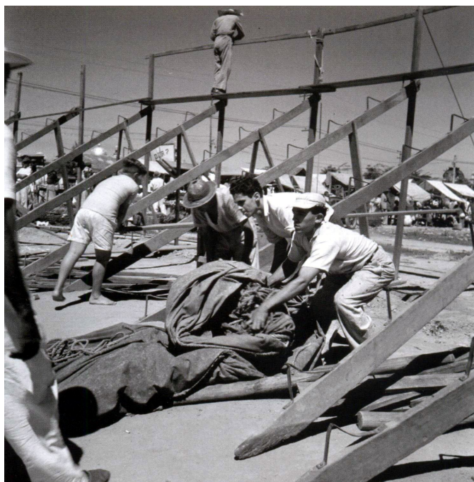
02- Circo Nerino, 1947. Montagem da estrutura do circo de pau-fincado. (Fonte: AVANZI & TAMAOKI, 2004, p 41)
