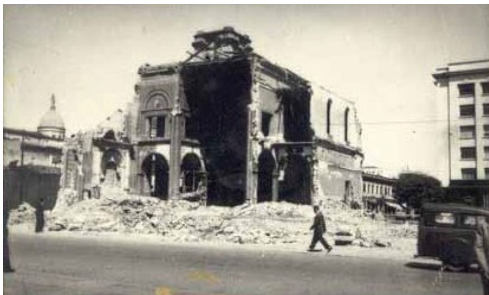
Foto 30: Demolição da Igreja do Rosário, 1956 (“Coleção V8” – CMU)
