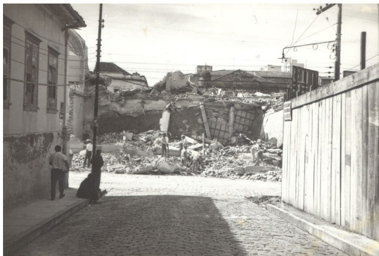
Fotos(a partir do alto) 34,35 e 36- Demolição do Teatro Municipal, 1965 (“Coleção V8” – CMU)
