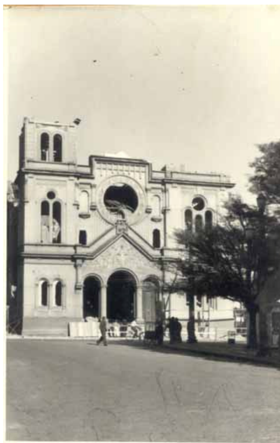
Foto 28: Demolição da Igreja do Rosário, em 1956 (“Coleção V8” – CMU)
