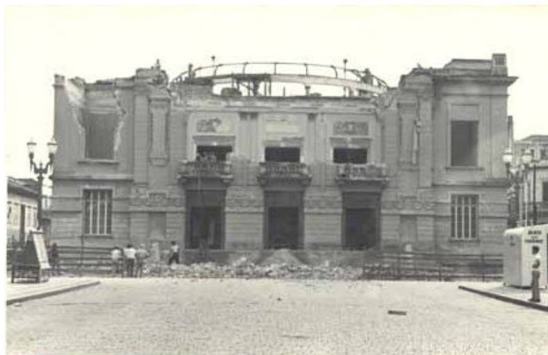
Foto 33: Demolição do Teatro Municipal, 1965 (“Coleção V8” – CMU)
