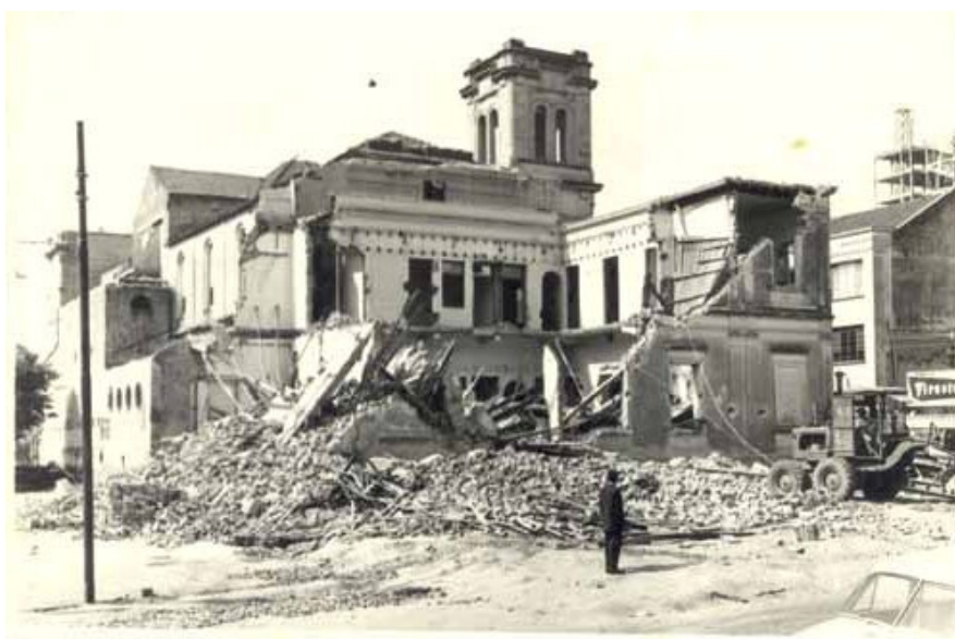
Foto 29: Demolição da Igreja do Rosário, 1956 (“Coleção V8” – CMU)
