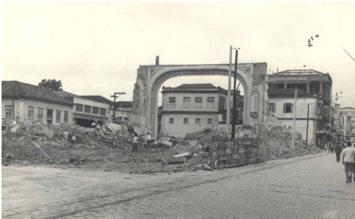
Foto 32: Demolição da Igreja do Rosário, 1956 (“ColeçãoV8”- CMU)
