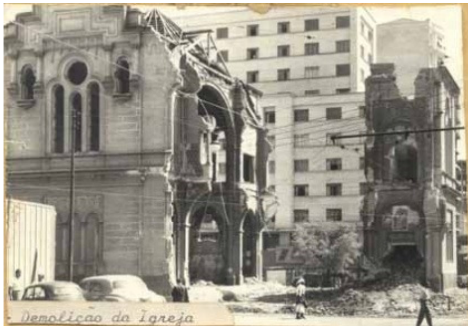
Foto 31: Demolição Igreja do Rosário, 1956 (Coleção V8- CMU)
