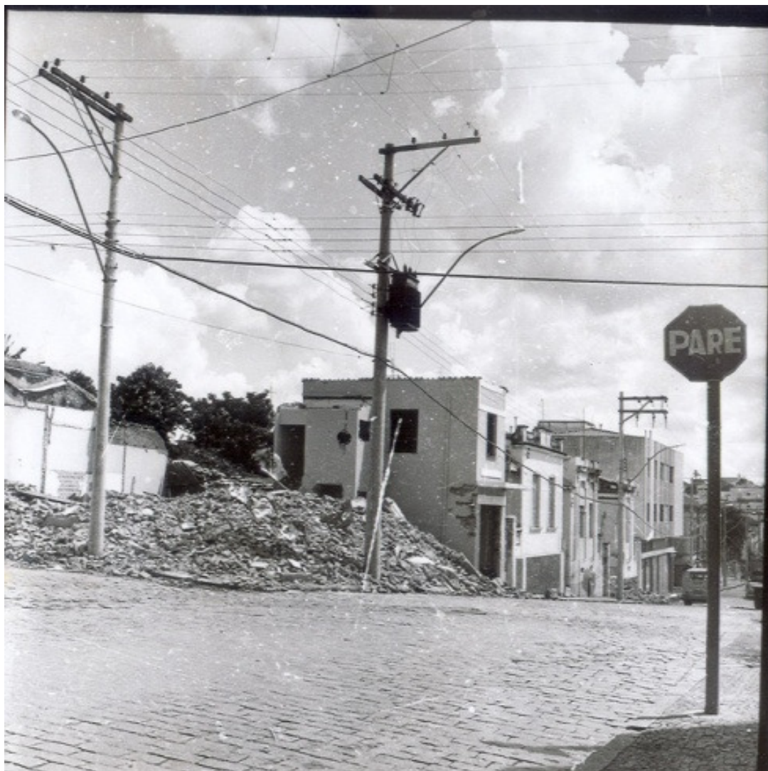
Foto 45- Escombros de casa demolida – 197... (Coleção V8-CMU)
