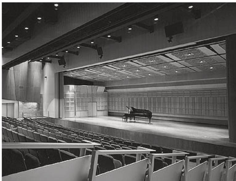
**Figura 5.10** – Difusores no palco do *Corning Glass Centre*, em Nova Iorque. Acima de cada elemento, após os difusores, pode-se observar uma aba a 45°. Fonte: Cox e D’Antonio (2004, p. 52, fig. 2.28)
