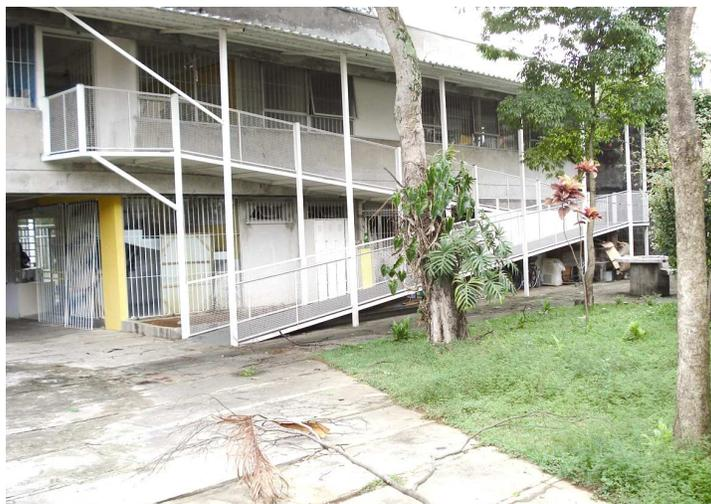
Figura 33 - Rampa construída para o acesso à sala de aula
