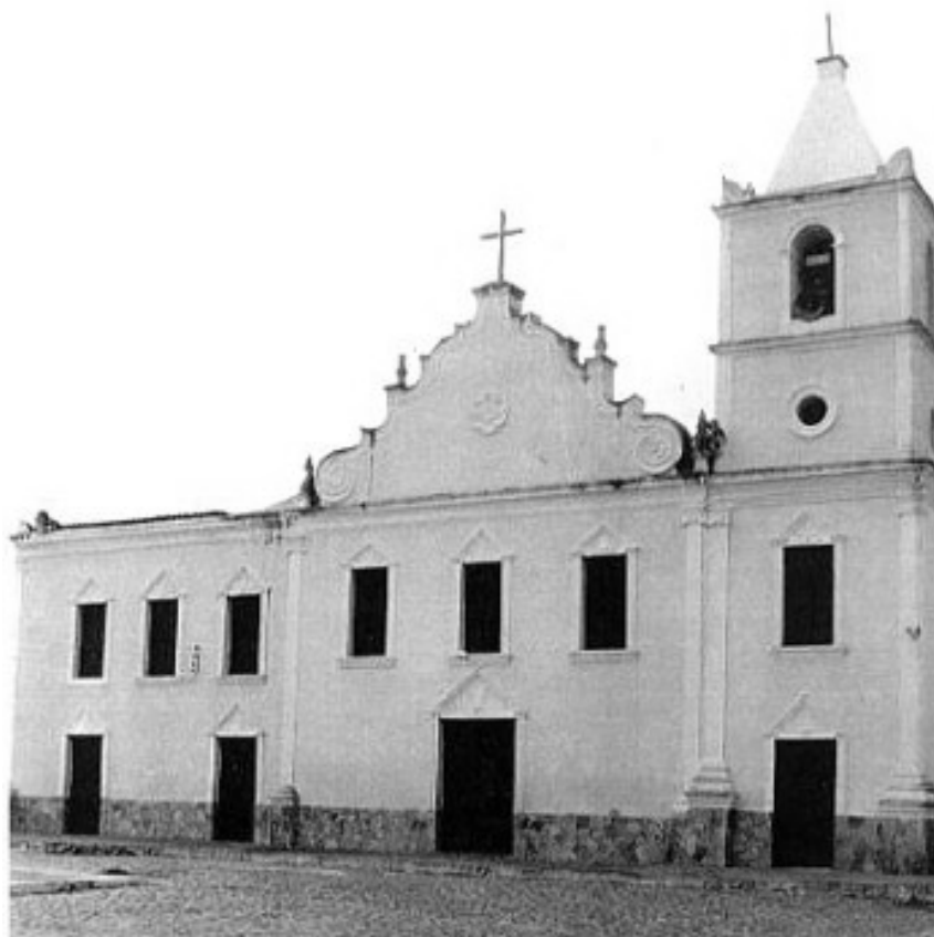
Figura 7 – Igreja da Aldeia das Guaraíras, atualmente no município de Arêz
