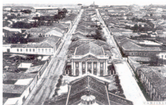
Vista parcial, Teatro São Carlos, 1890
