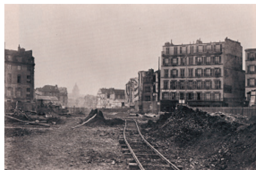
Charles Marville. Abertura de avenida, Paris, em torno de 1870.
