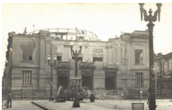
Demolição do Teatro Municipal Carlos Gomes, 1965
