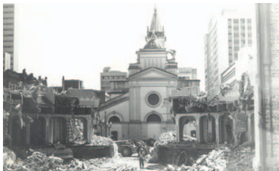
Demolição do Teatro Municipal Carlos Gomes, 1965
