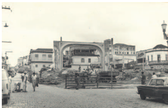
Demolição do Teatro Municipal Carlos Gomes, 1965
