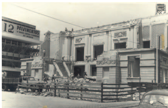
Demolição do Teatro Municipal Carlos Gomes, 1965
