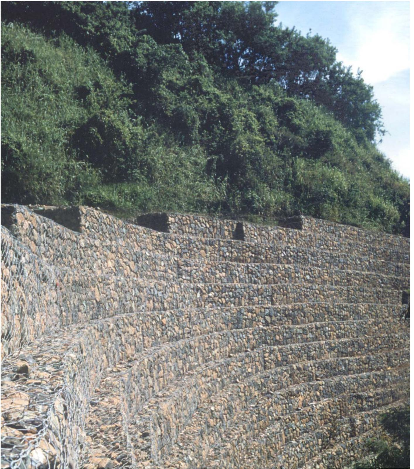
**FIGURA 37: Contenção de encosta feita pelo empilhamento de Gabião de tela de aço e pedra brita**
